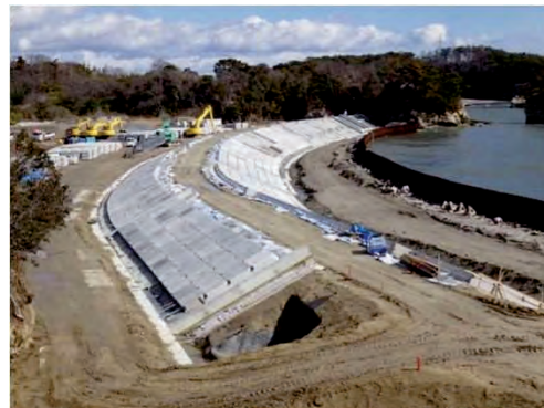
平成28年2月 現在 本復旧 施工中
