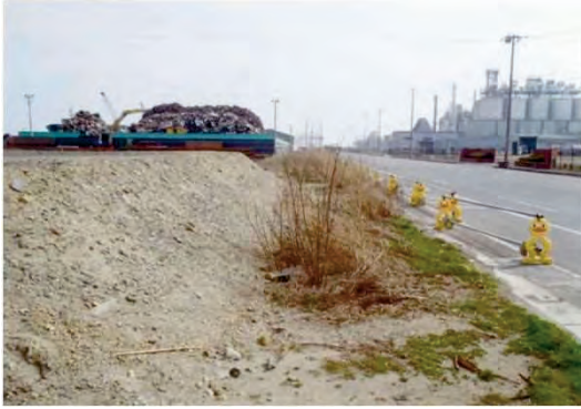
中島地区防潮堤(新設) 着工前
