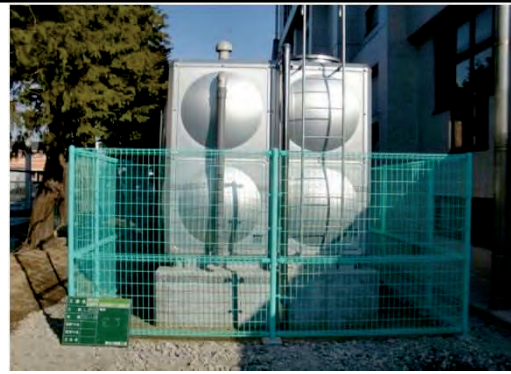
平成28年3月11日 完成 受水槽設置後
