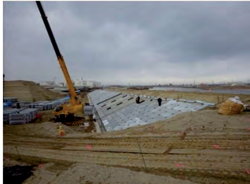
平成28年2月 現在 本復旧 施工中
