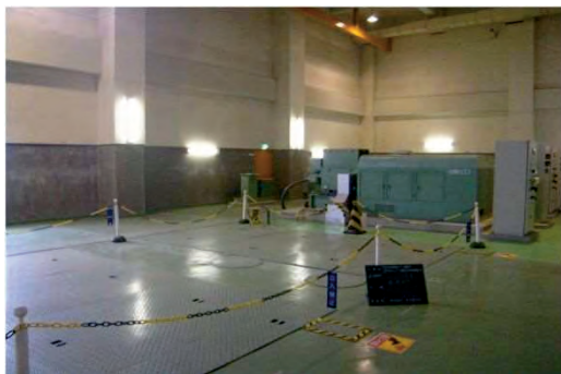
石巻浄化センター送風機増設 施工前
