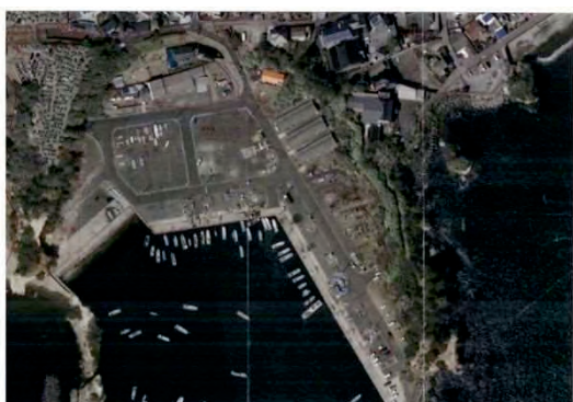
水産技術総合センター種苗生産施設新築工事 七ヶ浜町松ヶ浜字屋敷142, 143
