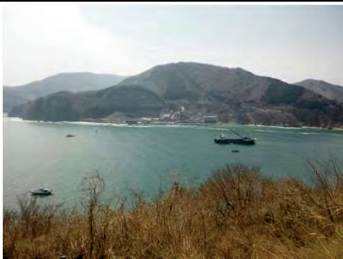
女川湾口防波堤 着工前
