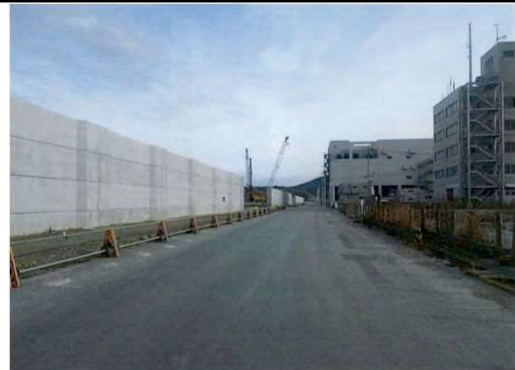
平成28年1月12日 完成 本復旧
