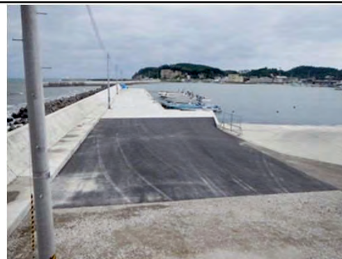
平成27年8月 完成 本復旧
