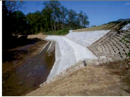
平成27年12月10日 完成 本復旧
