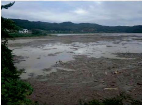
座主橋右岸部より貯水池を望む H27.9豪雨により貯水池に流木が大量に流入
