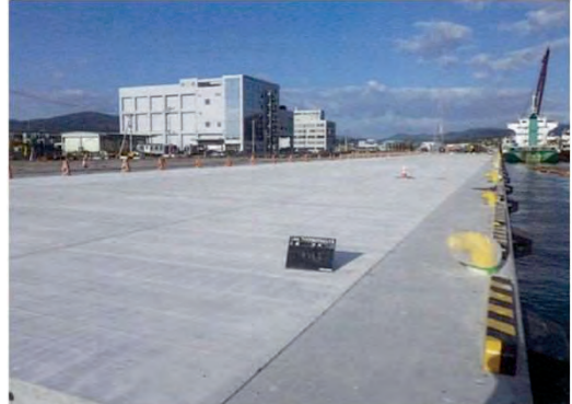
平成27年12月28日 完成 本復旧
