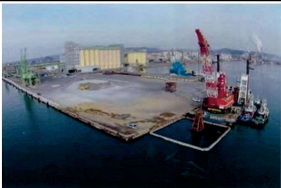
日和埠頭荷捌地 着工前
