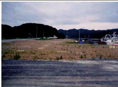
荻浜港荷捌地 着工前
