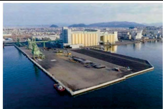
平成28年1月13日 本復旧完了
