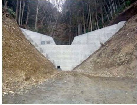
平成28年2月15日 完成 加茂堰堤改築工事
