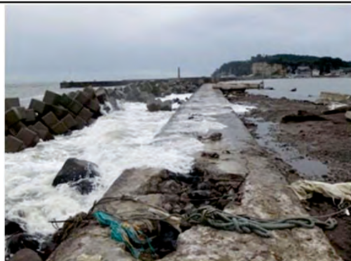
吉田浜防波堤 七ヶ浜町吉田浜字浜屋敷地先 被災状況（パラペット部の流出）
