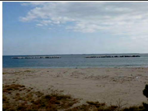
平成27年10月 完成 本復旧
