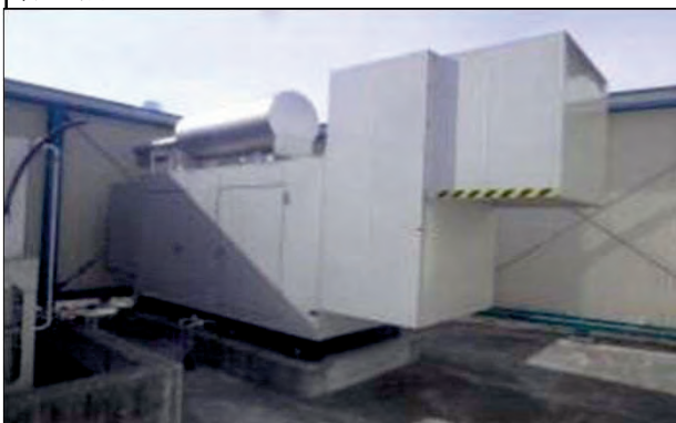
黒川郡大和町落合蒜袋地内 大和・大衡ポンプ場非常用自家発電設備災害復旧
