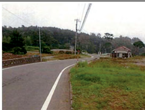
御崎港海岸防潮堤 気仙沼市唐桑町崎浜地内 津波被害
