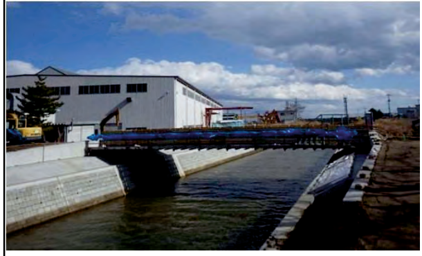
平成28年2月 現在 本復旧 施工中
