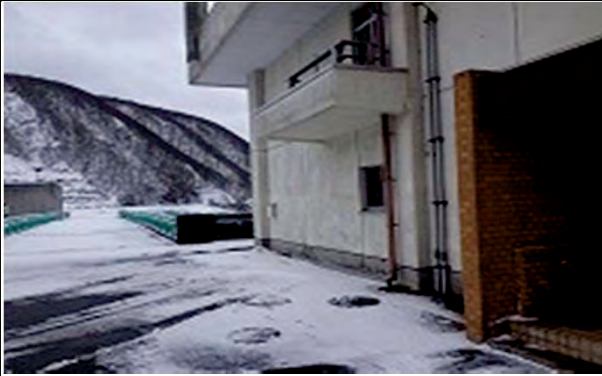
加美郡加美町字漆沢宮ヶ森地内 漆沢ダム附属施設（公衆トイレ）工事
