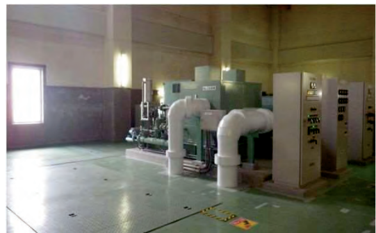
平成28年3月17日 完成 施工後
