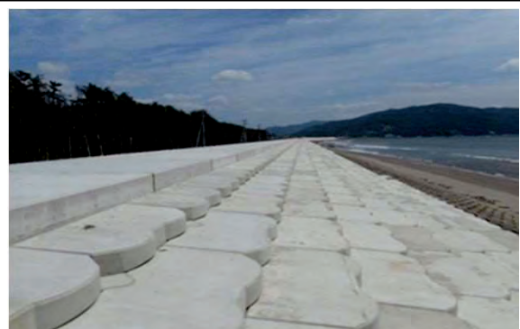
平成27年7月27日 完成 本復旧
