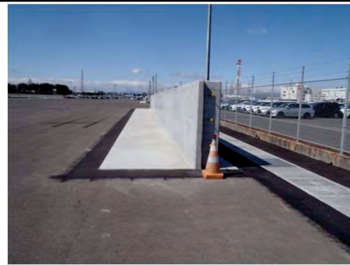
仙台港区防潮堤 雷神工区 新規防潮堤
