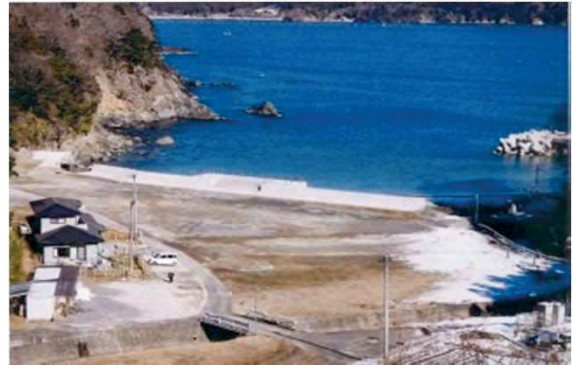
平成28年2月5日 本復旧完了
