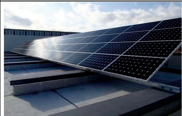
平成28年2月12日 完成 太陽光発電設備設置後
