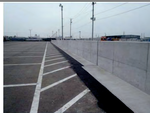
仙台港区防潮堤 中野6号工区 新規防潮堤
