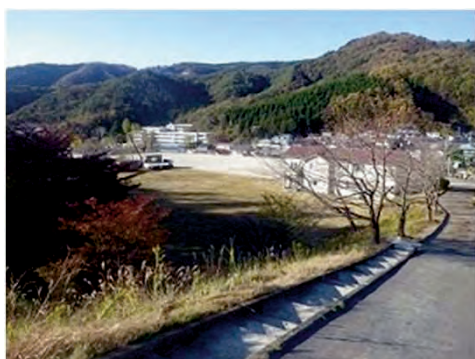
東部地区支援学校高等学園新築工事 牡鹿郡女川町浦宿浜字十二神60-3ほか
