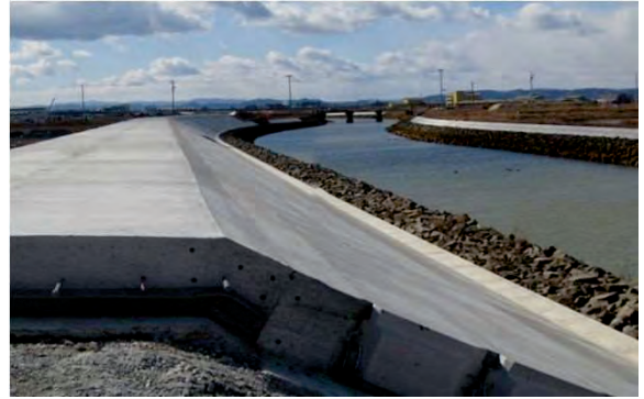
平成28年2月 現在 本復旧 施工中
