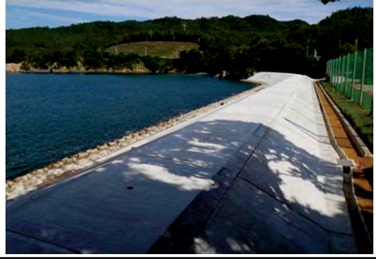
平成27年9月10日 完成 本復旧
