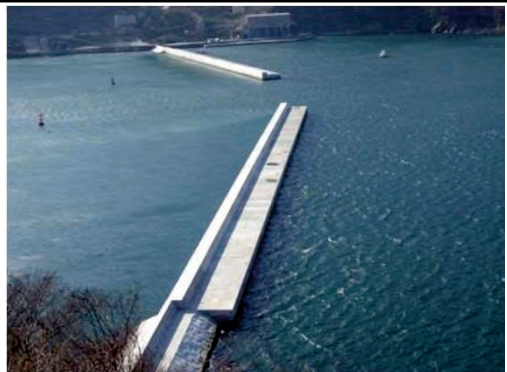
平成28年3月7日 本復旧完了
