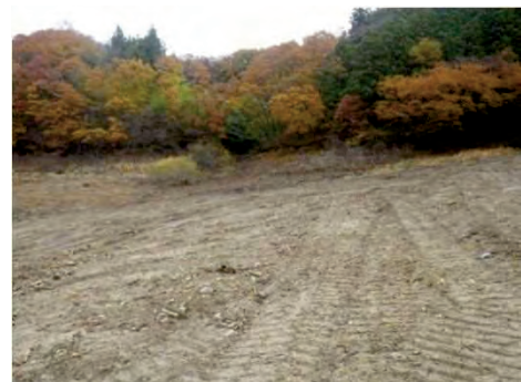
平成28年 1月29日 完成 本復旧（流木除去完了）
