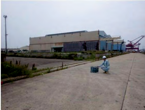
仙台港区防潮堤 仙台パワーステーション工区 着手前
