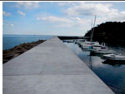
平成27年8月 完成 本復旧
