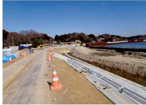
平成28年2月 現在 本復旧 施工中
