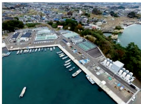
平成27年10月26日 完成 津波被災施設の移転・再整備
