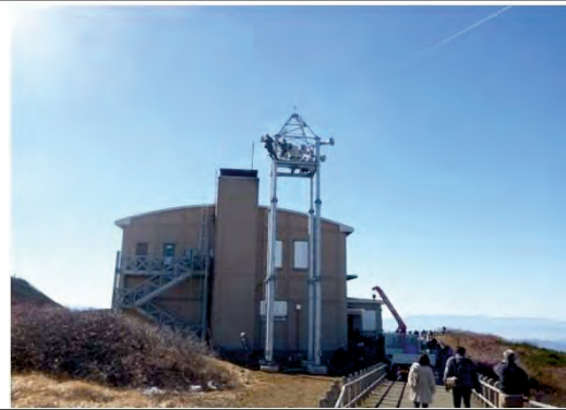
平成27年10月30日 完成 サイレン設備設置後
