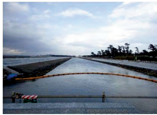
平成28年2月 現在 本復旧 施工中
