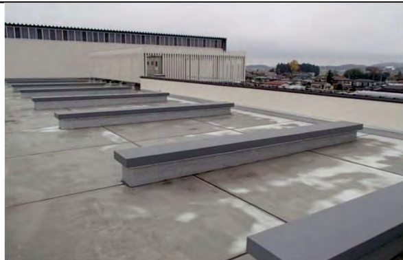
登米総合産業高 登米市上沼字北桜場223-1 太陽光発電設備設置前
