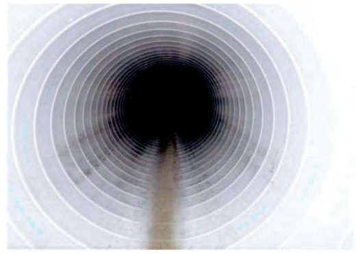
平成27年12月28日 完成（製管工法） 施工後
