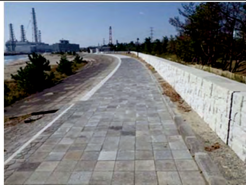
平成27年10月 完成 本復旧
