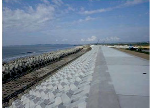
平成27年8月6日 完成 本復旧
