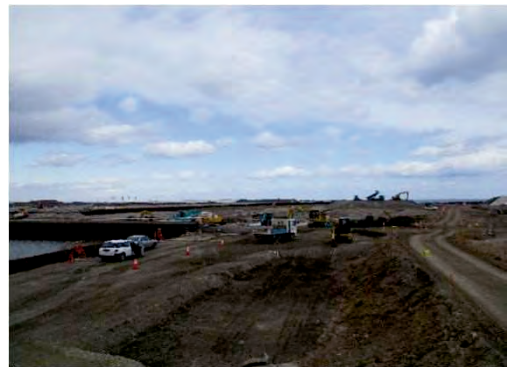
平成28年2月 現在 本復旧 施工中
