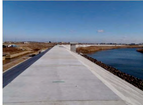
平成28年2月 現在 本復旧 施工中
