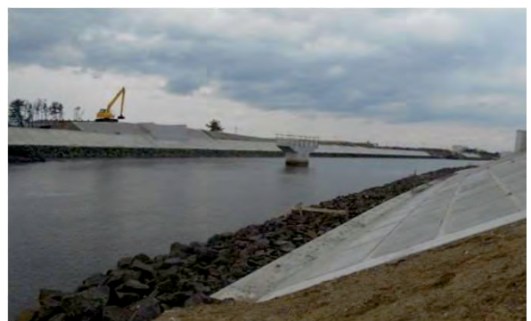
平成28年2月 現在 本復旧 施工中
