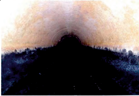
女川幹線管渠φ600 更生工 施工前
