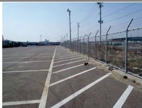
仙台港区防潮堤 中野6号工区 着工前
