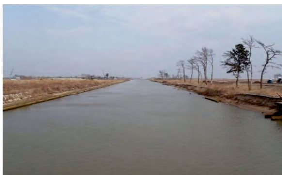
南貞山運河 名取市地内 河川堤防沈下
