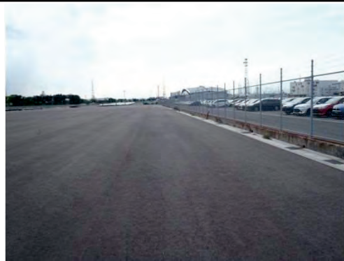
仙台港区防潮堤 雷神工区 着工前
