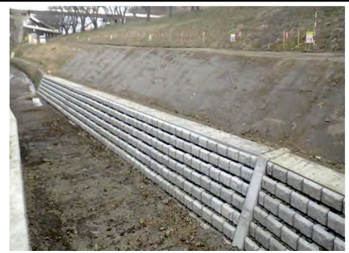
平成28年3月31日 完成 環境ブロック積工完了
