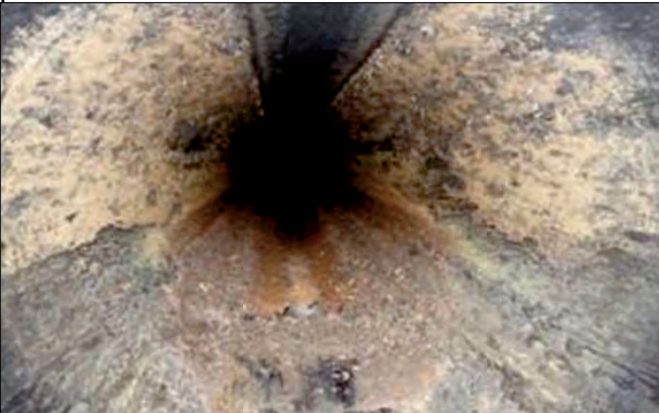
亶理郡亶理町荒浜地内外 亶理幹線（管渠）長寿命化
