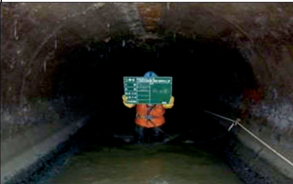
多賀城市大代地内 七北田川左岸幹線（管渠）長寿命化
