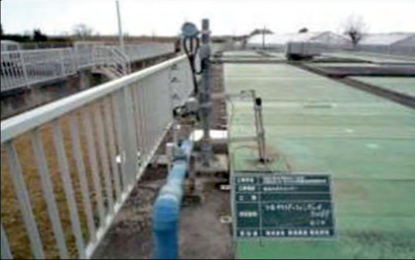
黒川郡大和町鶴巣地内外 大和浄化センター外デジタル保護計測装置等更新
