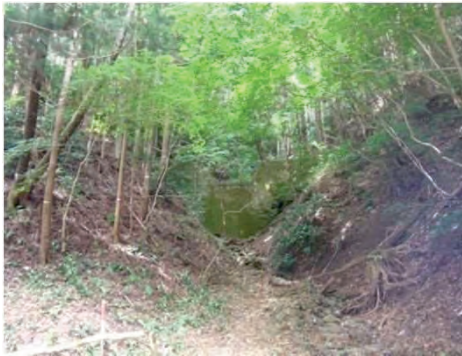
登米市津山町横山字本町 地内 砂防設備等緊急改築事業
