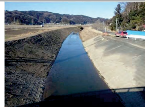
平成28年2月17日 完成 河道掘削工事完了
