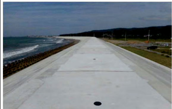
平成27年7月27日 完成 本復旧
