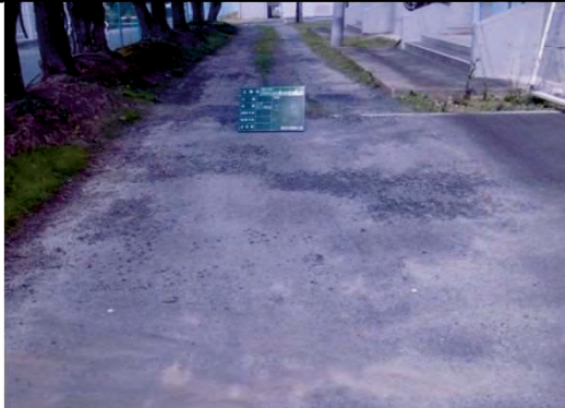
古川黎明中・高 大崎市古川諏訪一丁目4番26号 受水槽設置前
