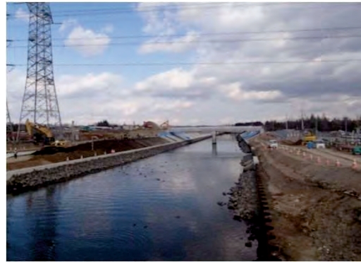
平成28年2月 現在 本復旧 施工中
