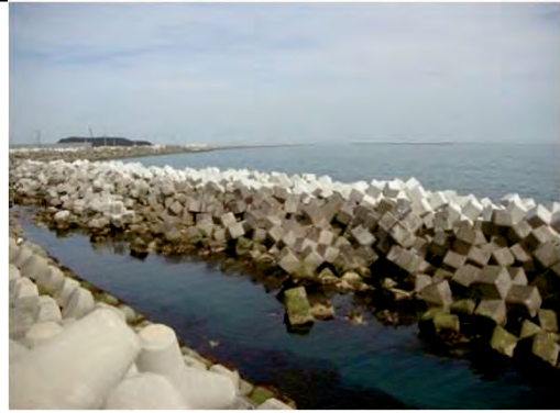
平成27年6月 完成 本復旧
