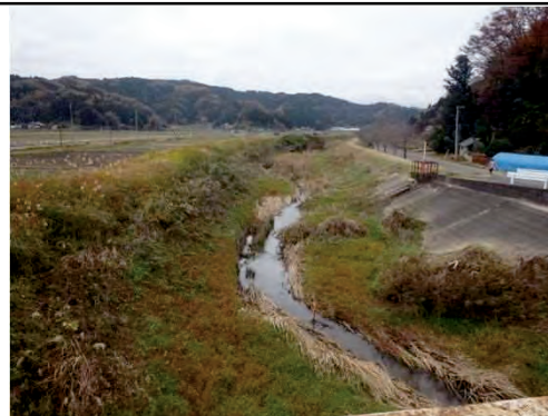
一級河川阿武隈川水系高倉川 角田市高倉字梅ヶ崎 柳茶屋橋
