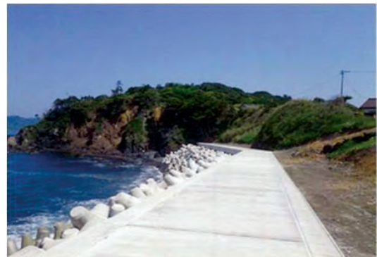
平成27年5月25日 完成 本復旧
