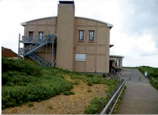
蔵王レストハウス 刈田郡七ヶ宿町刈田岳国有林内 サイレン設備設置前
