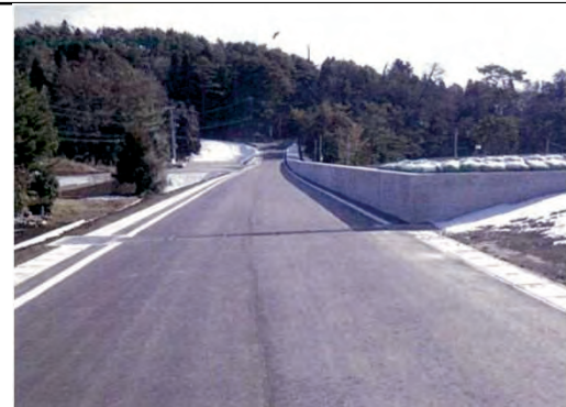
平成28年2月12日 完成 完成
