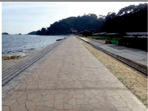
平成27年11月 完成 本復旧
