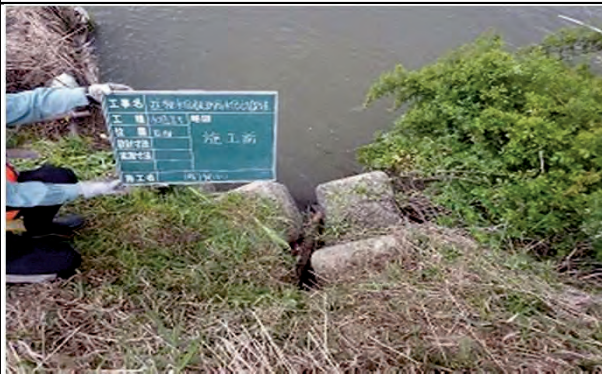
加美郡加美町字薬師堂地内 並柳水位観測局水位計修繕工事
