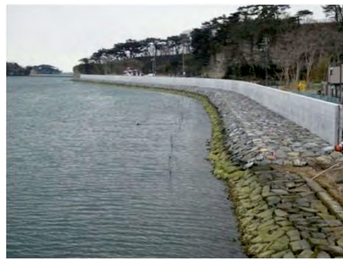
平成28年2月 現在 本復旧 施工中
