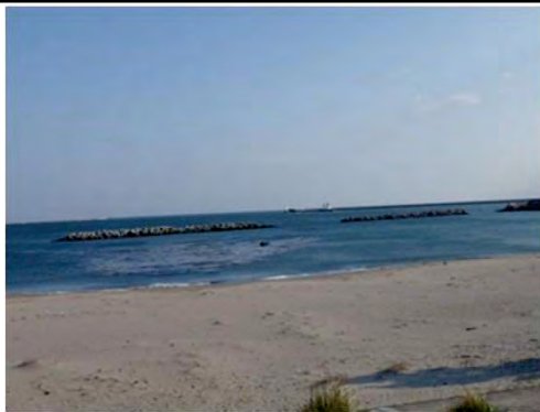
湊浜離岸堤 宮城郡七ヶ浜町湊浜地先 被災状況（流失及び沈下）
