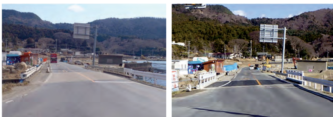
(主)石巻鮎川線 大原浜橋災害復旧工事 (左:着手前, 右:完成)
