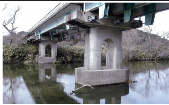
(一) 柳沢中新田線 河原橋 橋脚耐震補強
