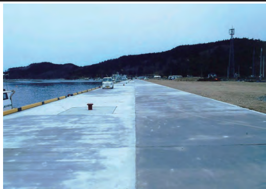
平成27年3月20日 本復旧完了
