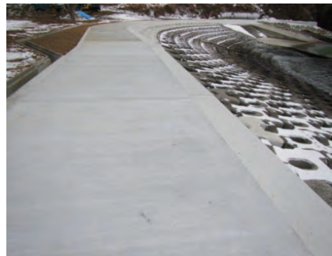
平成27年1月26日 完成 本復旧
