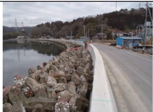
平成27年2月4日 完成 本復旧
