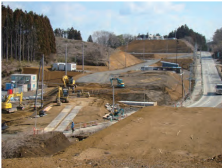
国道398号 南三陸町戸倉字波伝谷地内 現道嵩上げのため迂回路施工中
