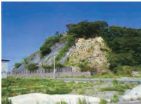
(一) 石巻雄勝線 石巻市八幡町地内 八幡町災害防除工事
