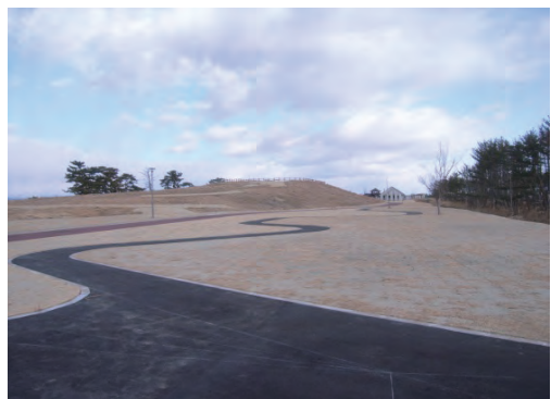
平成27年2月 現在 本復旧 施工中
