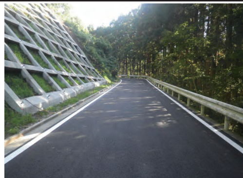
平成27年3月5日 本復旧完了
