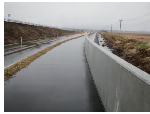
平成27年3月27日 完成 本復旧
