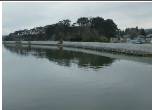
平成27年2月 現在 本復旧 施工中
