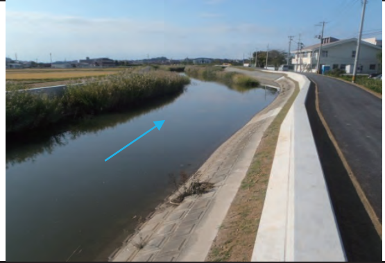
平成26年9月30日 完成 本復旧
