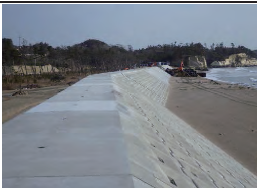
平成27年2月 現在 本復旧 施工中
