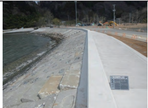
平成26年3月10日 完成 本復旧
