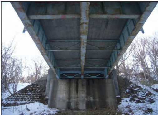
国道457号 川崎町前川地内 川音橋
