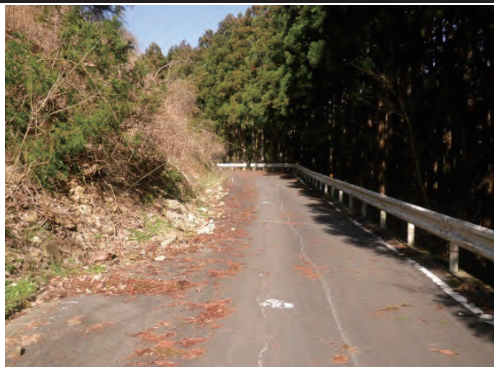
(一)石巻雄勝線 石巻市真野地内 法面崩壊・道路舗装損傷状況
