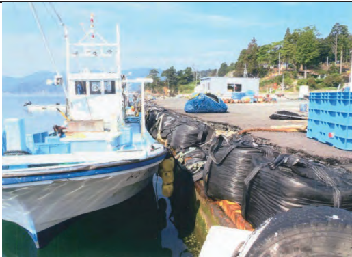
雄勝港大浜地区 着工前
