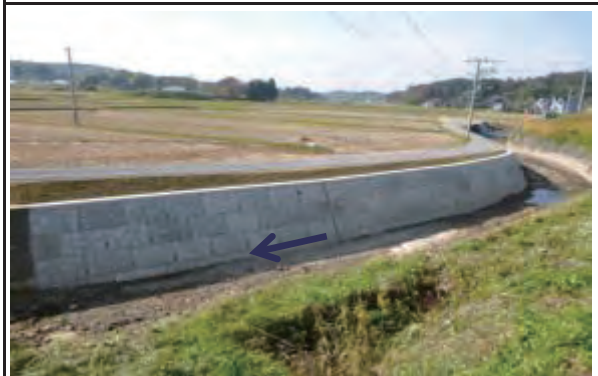
平成26年10月30日 復旧工事完了
