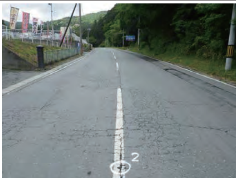
主要地方道 女川牡鹿線 女川町小乗浜地内 小乗浜(1)外道路災害復旧工事
