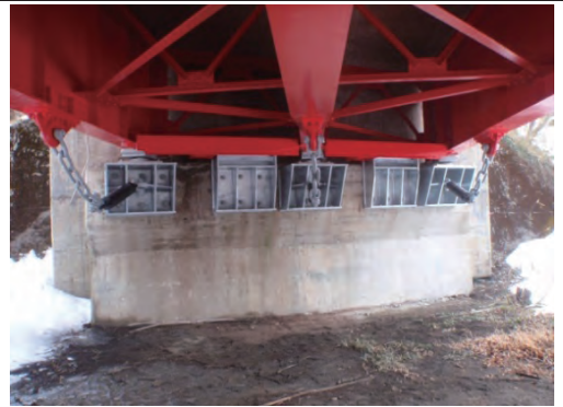
平成27年3月9日 完成 清水原橋耐震補強工事完了
