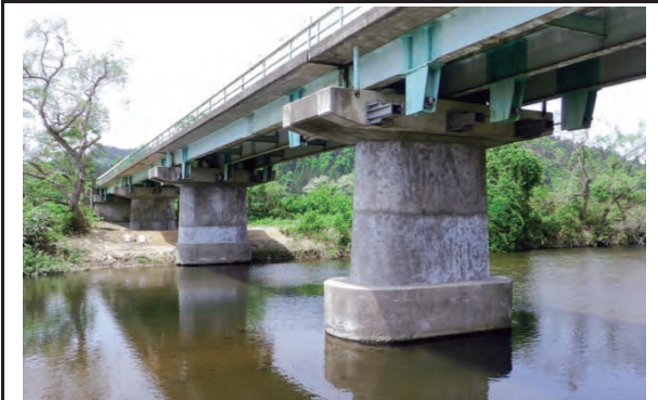
平成26年6月30日 完成 補強後
