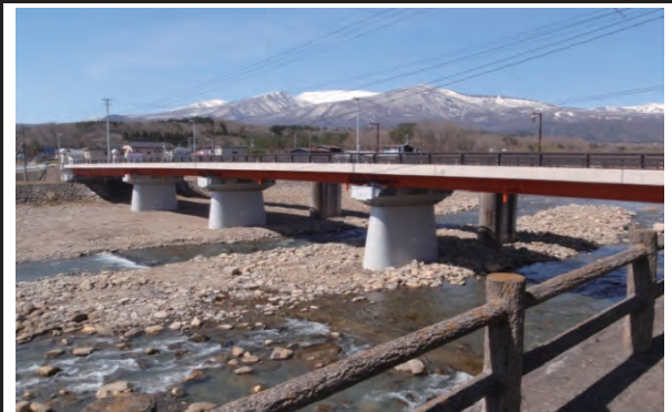
平成26年5月30日 完成 遠刈田橋耐震補強工事完了
