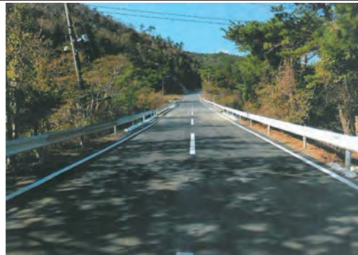
平成26年10月20日 本復旧完了
