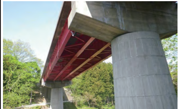
平成26年5月20日 完成 深洞橋耐震補強工事完了
