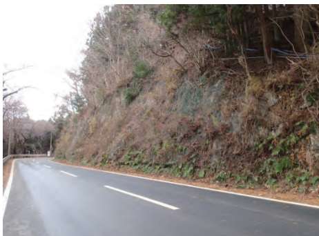
(国)398号 女川町石浜字崎山地内 崎山災害防除工事(その2)
