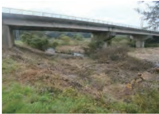
一般県道文字上尾松線 栗原市栗駒文字津花地内 津花橋耐震補強工事
