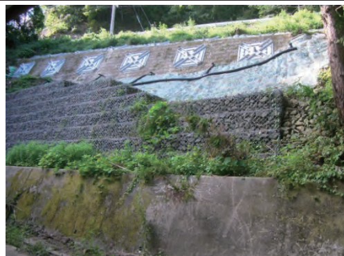
平成26年10月23日 完成 大平山災害防除工事完了
