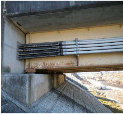
主要地方道白石丸森線 白石市東町地内 雁狩橋
