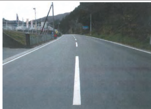
平成27年1月5日 本復旧完了
