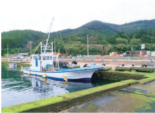
雄勝港立浜地区 着工前
