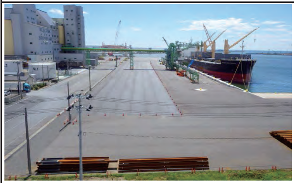
平成26年11月28日 本復旧完了
