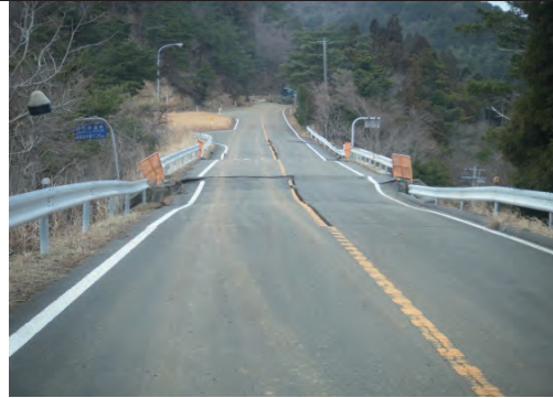
一般県道 牡鹿半島公園線 石巻市新山浜地内 新山浜災害防除外工事
