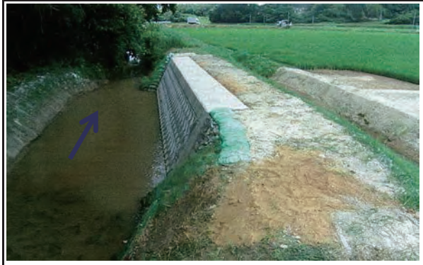
平成26年6月30日 復旧工事完了
