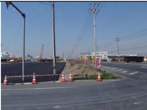
大手地区防潮堤（新設） 着工前
