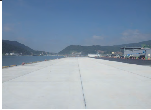
平成26年10月22日 本復旧完了
