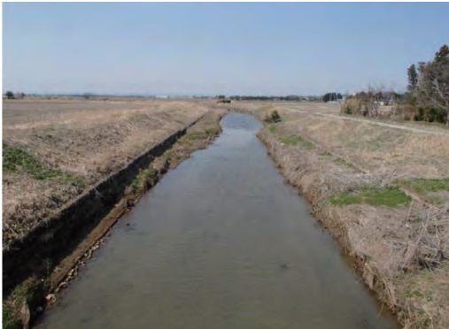
一級河川出来川 遠田郡涌谷町九軒 河道掘削工事
