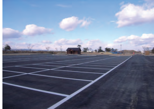
平成27年2月 現在 本復旧 施工中
