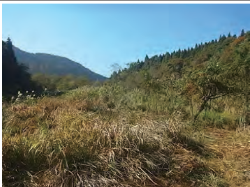
一級河川江合川 大崎市鳴子温泉新小身河原 河道掘削工事
