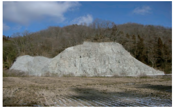
平成27年2月3日 完成 筆甫川下三災害防除工事完了
