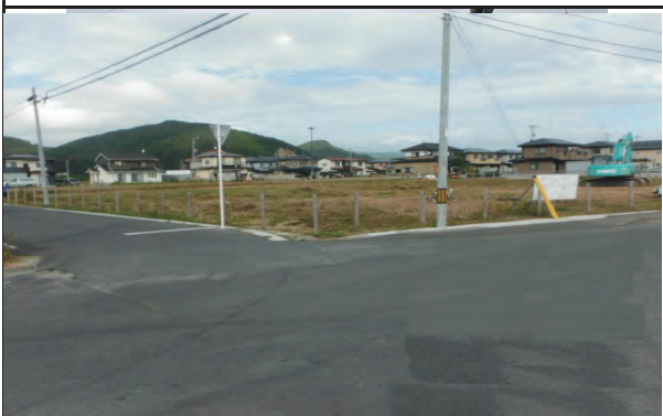
平成25年9月5日 着工 黄金浜地区 石巻市渡波地内
