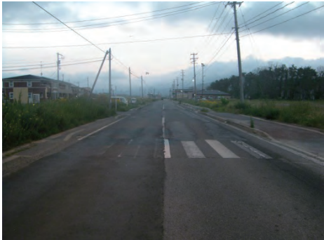
国道398号 石巻市渡波地内 渡波道路災害復旧工事
