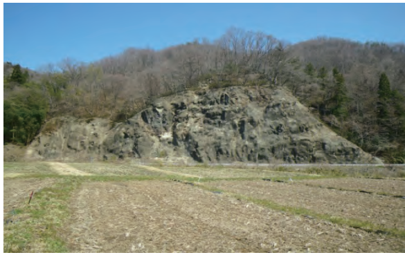
主要地方道丸森霊山線 丸森町筆甫川下三地内 筆甫川下三災害防除工事 着工前
