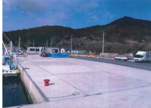
平成27年3月12日 本復旧完了
