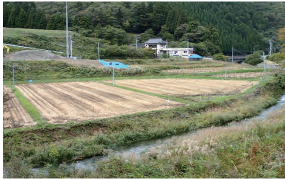
八瀬川 気仙沼市塚沢地内 河川護岸法欠
