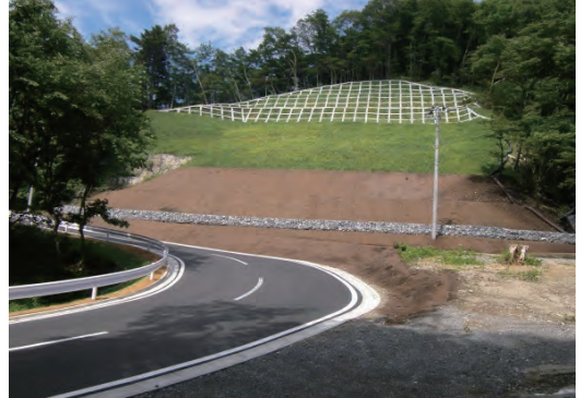
平成26年7月30日 本復旧完了
