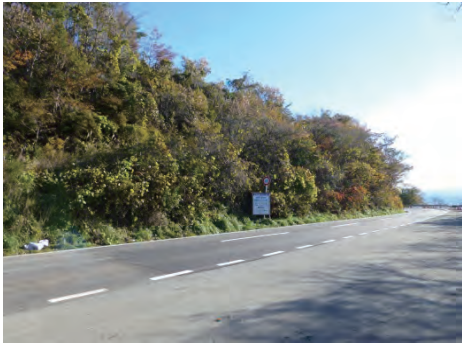
(国) 398号 女川町石浜字崎山地内 崎山災害防除工事
