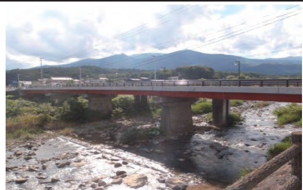
国道457号 蔵王町遠刈田温泉地内 遠刈田橋
