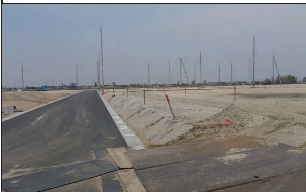
平成26年4月8日 着工 玉浦西地区 岩沼市押分地内
