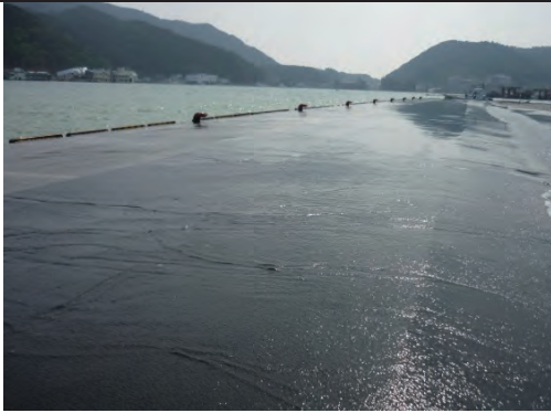
女川港石浜地区 着工前
