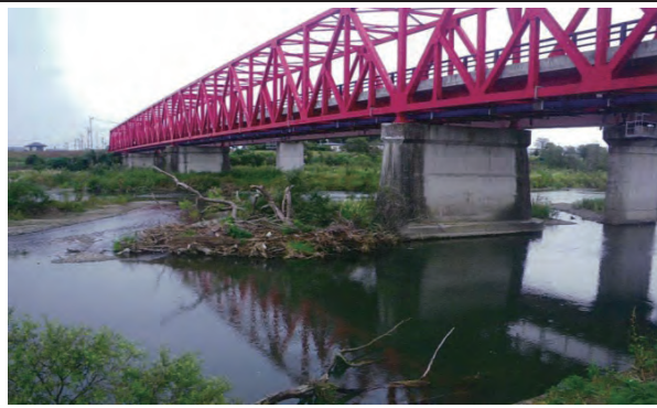
(主) 古川一迫線 桜ノ目橋 橋脚耐震補強
