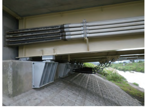
平成27年3月18日 完成 雁狩橋耐震補強工事完了
