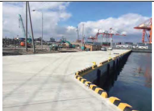
平成27年3月 完成 本復旧
