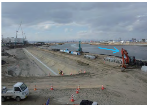
平成27年2月 現在 本復旧 施工中
