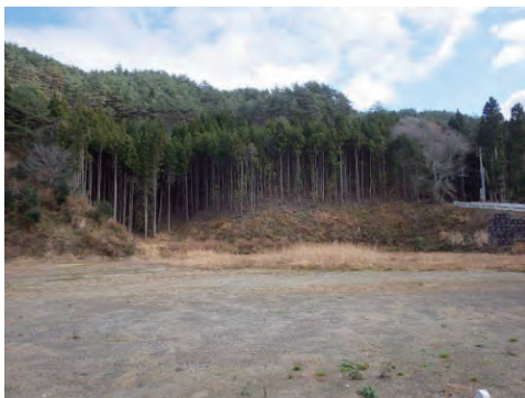
平成26年5月 着工 舞根トンネル 気仙沼市東舞根地内
