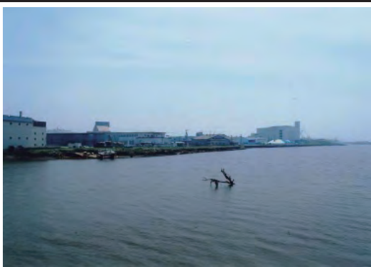
重吉地区防潮堤(新設) 着工前
