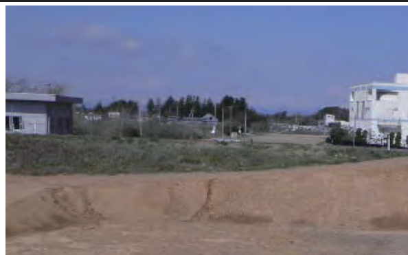
平成25年2月26日着工 長沼川 長沼川排水樋門 登米市南方寺袋
