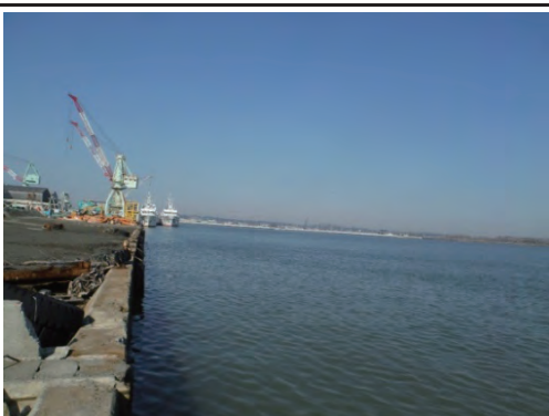
西水路南地区防潮堤（新設） 着工前
