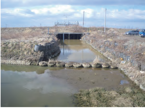
一級河川百々川 大崎市田尻大沢 百々川排水機場（躯体下部・機械設備工）
