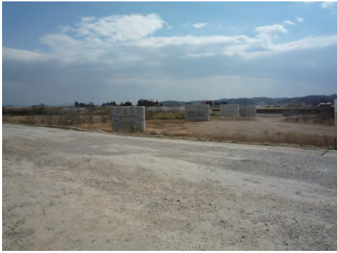
(主) 古川松山線 大崎市古川下中目地内 下中目(志田橋)道路改良工事
