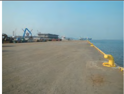
平成26年9月 完成 本復旧
