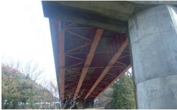
国道113号 七ヶ宿町滝ノ上地内 深洞橋
