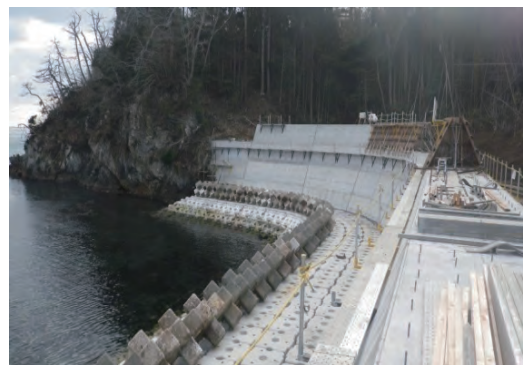
平成27年2月 現在 本復旧 施工中
