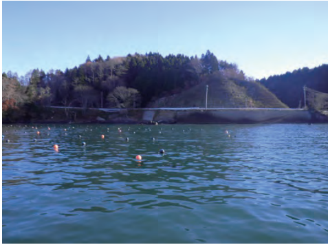
県道泊崎半島線 南三陸町歌津字館浜地内 道路法面崩落
