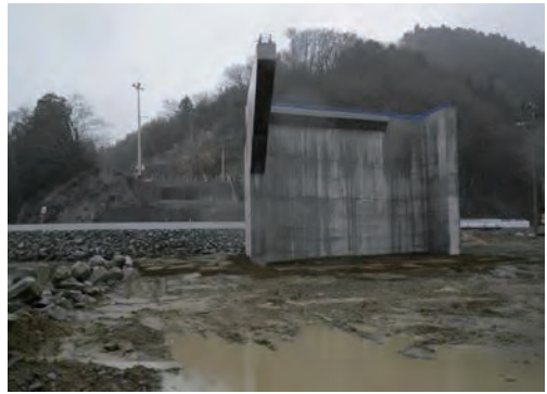
平成27年3月12日 本復旧完了
