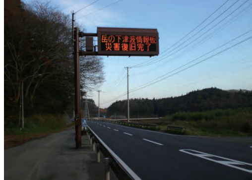
平成26年11月18日 津波情報表示板本復旧完了
