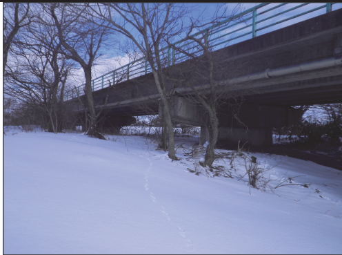
(一) 小野田三本木線×一級河川鳴瀬川 旭橋 加美郡加美町月崎 橋梁耐震補強工事
