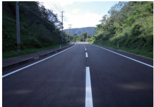
平成26年10月31日 本復旧完了
