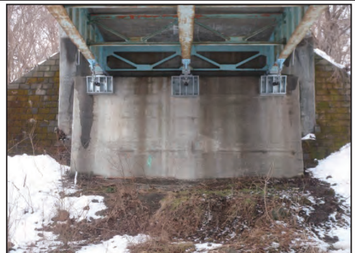
平成27年3月9日 完成 川音橋耐震補強工事完了
