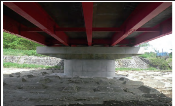
平成26年5月30日 完成 秋山沢橋耐震補強工事完了
