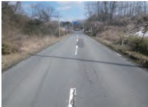
一般県道有壁停車場線 栗原市金成有壁 舗装補修工事
