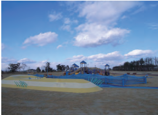
平成27年2月 現在 本復旧 施工中
