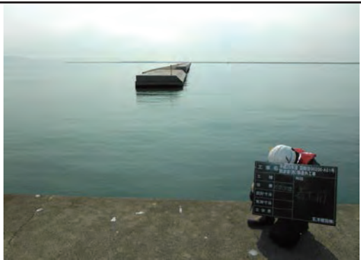
西防波堤 着工前
