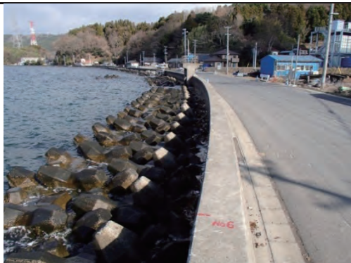
針浜地先海岸 女川町針浜地内 堤防沈下等
