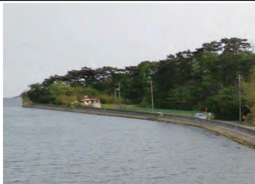
高城川 松島町高城地内 河川堤防沈下
