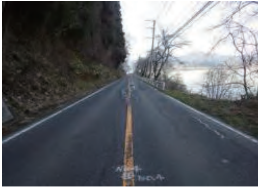
国道398号 栗原市花山天ヶ沢地内 舗装補修工事
