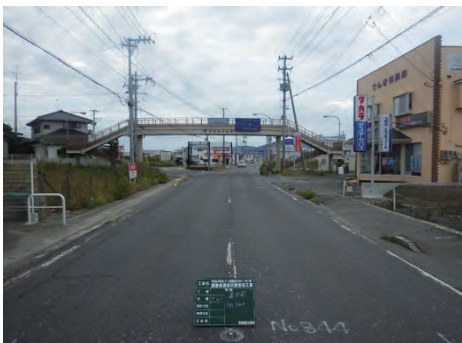
国道398号 石巻市鹿妻南地内 鹿妻南道路災害復旧工事
