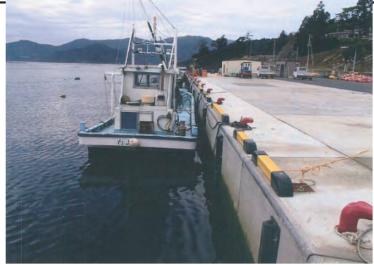
平成26年11月4日 本復旧完了
