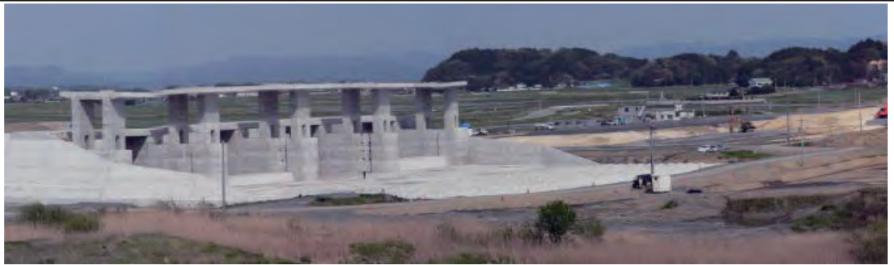
昭和46年事業採択 昭和50年建設着手(平成19年5月 主ダム施工中) 長沼ダム 登米市迫町北方地内
