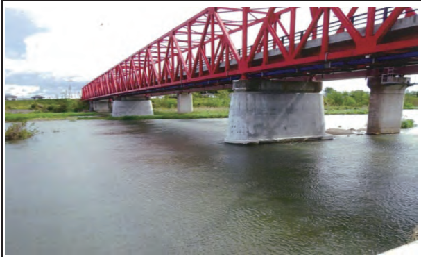
平成26年6月19日 完成 補強後
