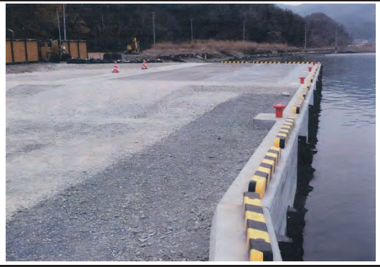
平成27年3月23日 本復旧完了
