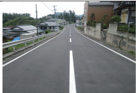
平成26年2月28日 本復旧完了
