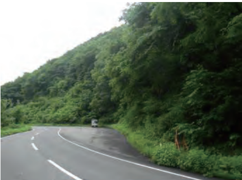
国道347号 加美町漆沢字嶽山地内 落石防護柵工
