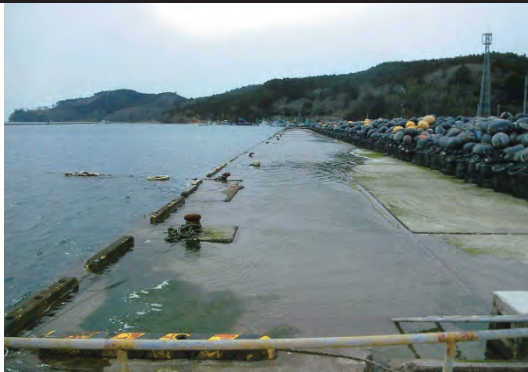
荻浜港 着工前
