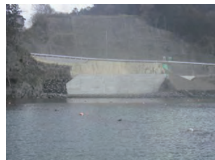
館浜道路災害復旧の完成状況
