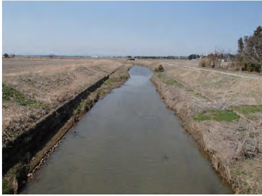
出来川河道掘削 着手前
