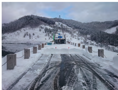
地震計更新工事状況
