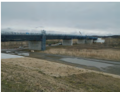
(主)古川松山線 下中目(志田橋)道路改良工事
