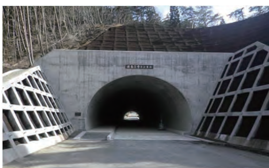
浦島2号トンネルの完成状況
