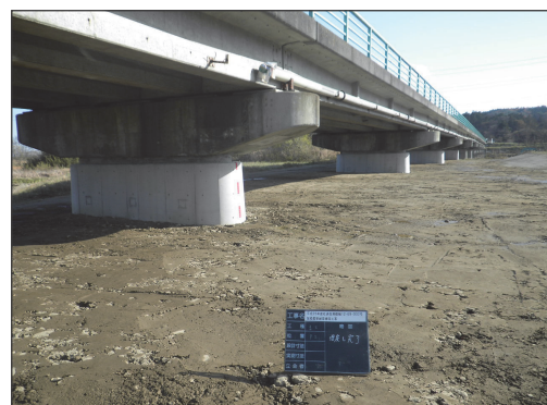
コンクリート巻立て完了
