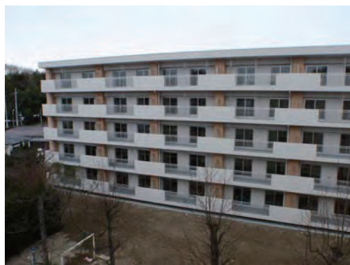
○県営名取手倉田第二住宅（H25.12 建替復旧完成）
