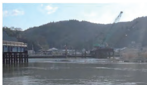
内海橋の施工状況（左岸側）
