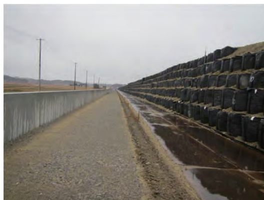
災害復旧工事調整後
