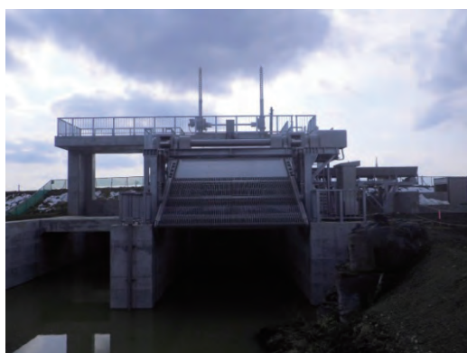
百々川排水機場 機械設備完了
