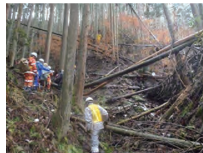
川内沢ダム建設事業 用地測量による現地立会い状況
