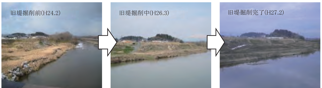
迫川若柳狭窄部の旧堤防掘削経過
