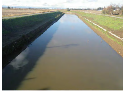
出来川河道掘削 完了
