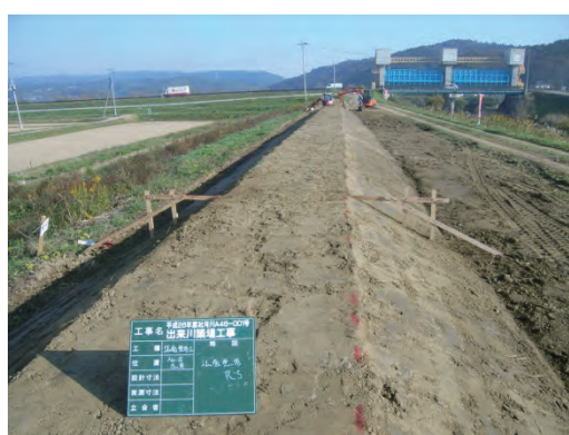
出来川築堤 施工中
