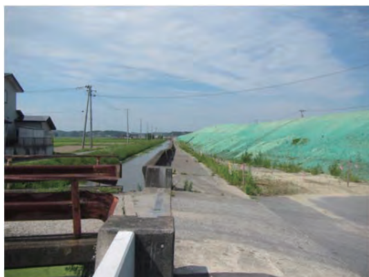
災害復旧工事調整前
