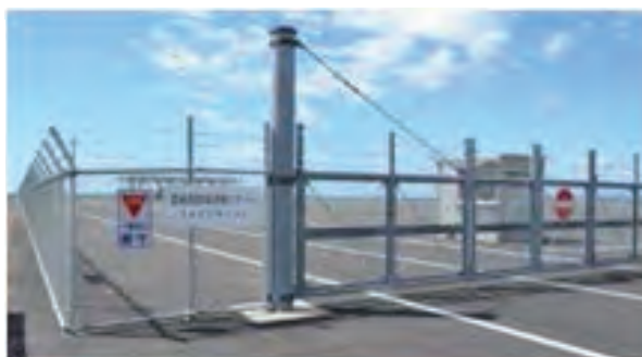
復旧したSOLAS フェンスとゲート 【雲雀野北埠頭】
