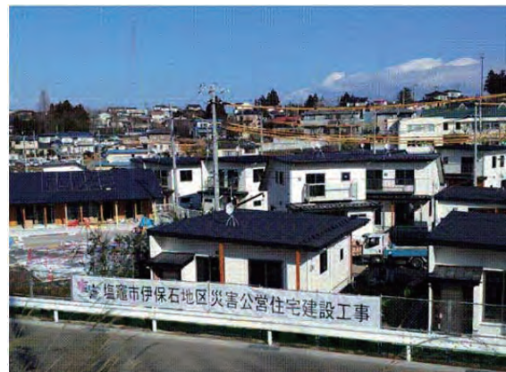
塩竈市伊保石地区災害公営住宅
