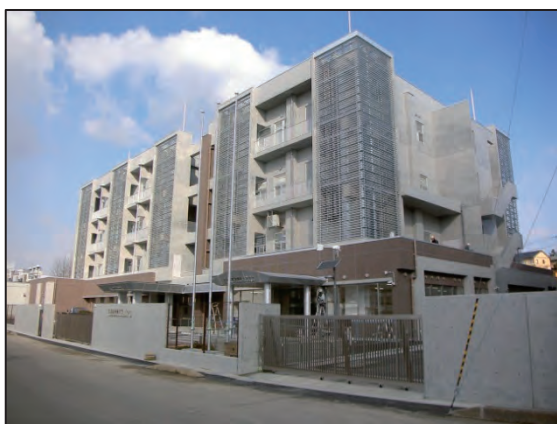
保健環境センター(完成 H27.2.)
