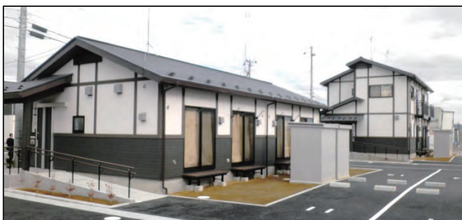
東松島市東矢本駅北地区(完成)
