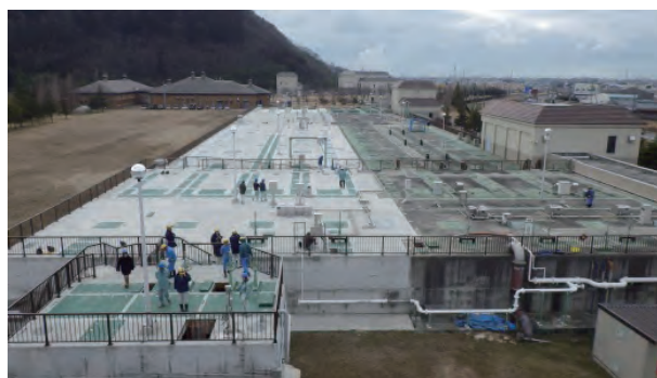
供用開始した第2系列 1/2 水路
