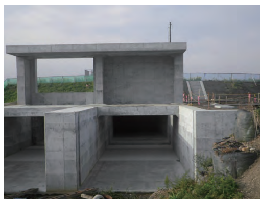
百々川排水機場 下部躯体完了
