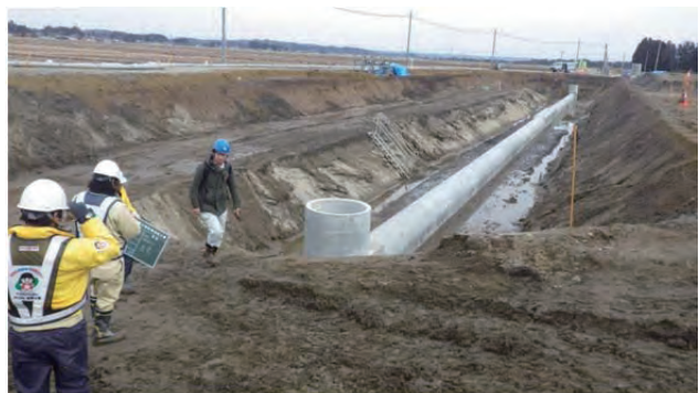
設計協議による下水道管の布設替え
