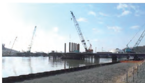
内海橋の施工状況（右岸側）
