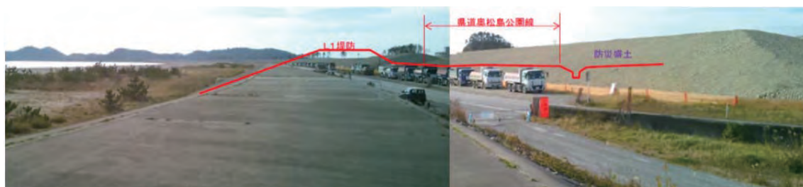
州崎海岸の現況
