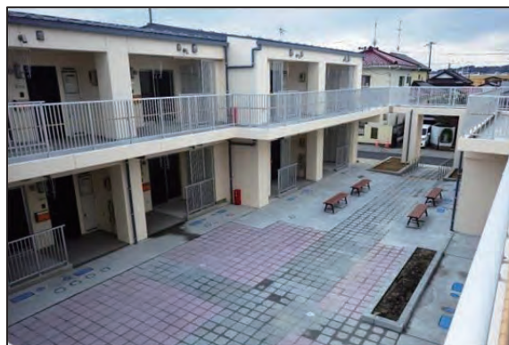
東松島市矢本東保育所跡地地区(完成)
