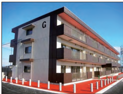
石巻市新蛇田A-1街区地区(完成)
