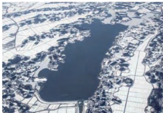
<長沼ダム全景> (試験湛水洪水時最高水位到達時)
