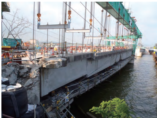
(一)石巻工業港矢本線 定川大橋旧橋撤去工事 (左:上部工撤去, 右:下部工撤去)
