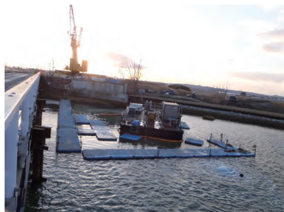
(一)石巻工業港矢本線 定川大橋旧橋撤去工事 (左:上部工撤去, 右:下部工撤去)
