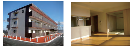
12日 岩沼市玉浦西地区災害公営住宅完成
