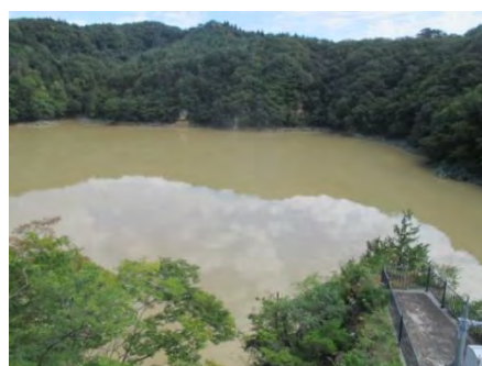
【花山ダム貯水池濁水状況 H27.9.14】
