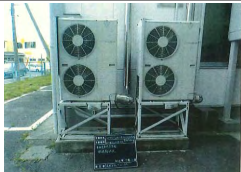
④ 平成29年7月7日 着工 仙台市泉区将監地内 仙台地方ダム総合事務所
