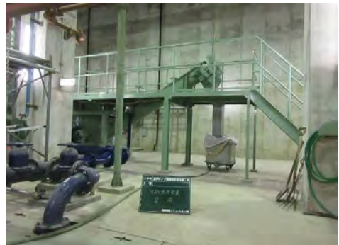
④ 平成30年3月14日 完成
