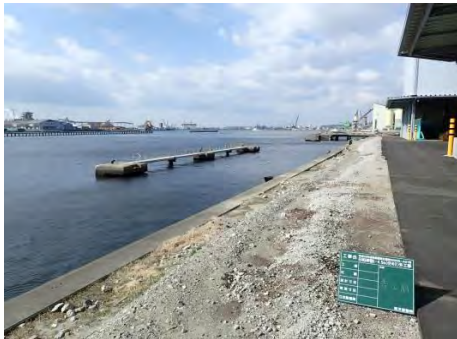
④平成27年2月19日着工 日和岸壁（-4.5m）（その2）外工事
