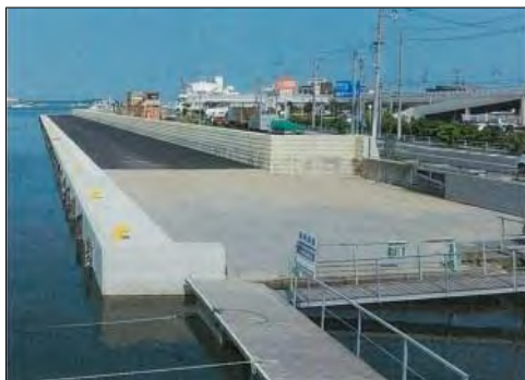
千賀の浦観光光揚場災害復旧工事 (塩釜港区)
