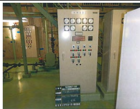
② 平成30年3月 現在 汚泥処理施設（機械濃縮機）電気設備工事完了後
