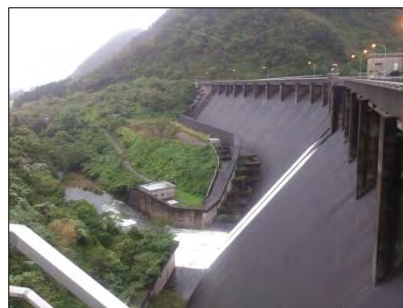
南川ダム洪水調節 (平成 29年 9月 18日)
