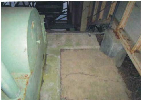
② 平成29年11月2日 着工 名取市高館川上地内 樽水ダム
