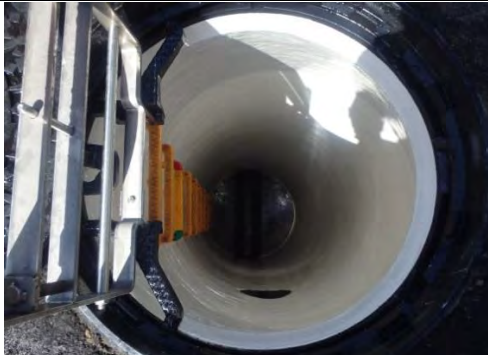
④ 平成29年9月 現在 修繕工事完了後
