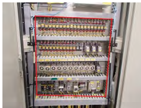
③ 平成30年3月 現在 運転制御（水処理）長寿命化工事完了後
