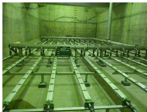
写真3. 反応タンク散気装置
