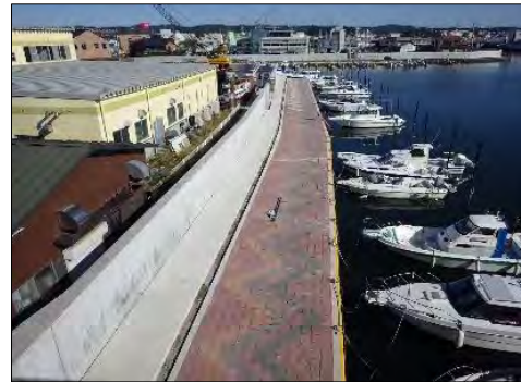
中の島胸壁外災害復旧工事 (塩釜港区)
