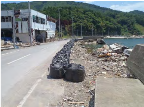
⑦平成26年11月28日着工 大浜防潮堤外災害復旧工事
