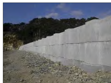
寒風沢防潮堤工事 (※施工中) (塩釜港区)
