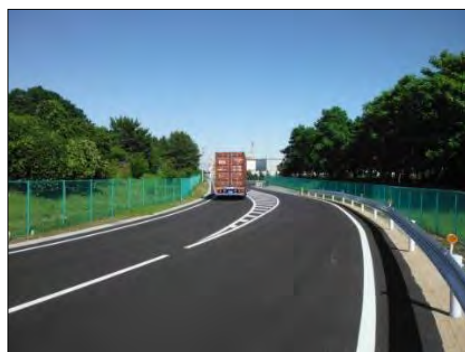
臨港道路ふ頭8号線新設工事 (仙台港区)
