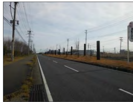
津波漂流物対策施設設置工事 (蒲生幹線) (仙台港区)
