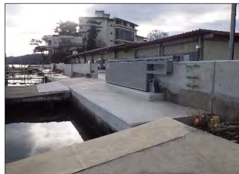
東浜胸壁外災害復旧工事 (松島港区)
