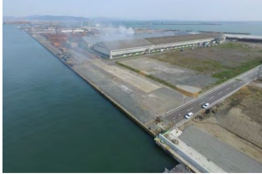
③平成28年2月18日着工 西水路南地区防潮堤（その3）工事
