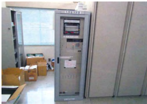
① 平成28年11月18日 着工 名取市高館川上地内 樽水ダム
