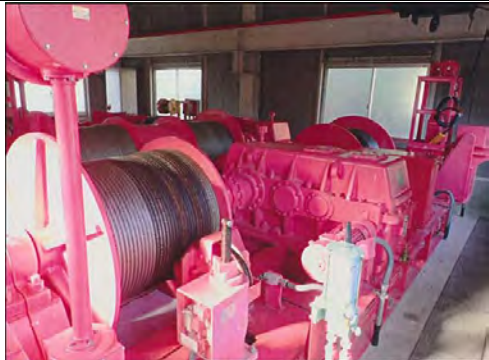
② 花山ダム 栗原市花山字本沢向原地内 花山ダム取水ゲート下段扉ワイヤーロープ交換
