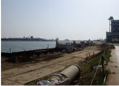
⑥平成27年2月27日 日和岸壁(-4.5m) (その3) 外工事
