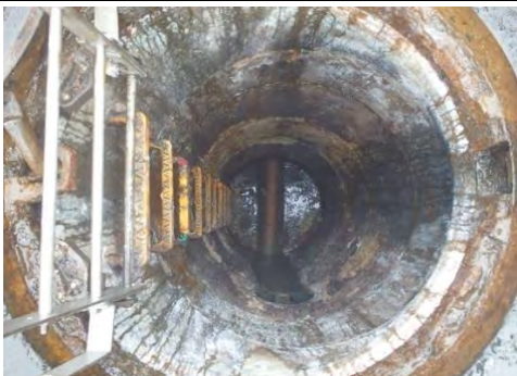
④迫川左岸幹線人孔 栗原市栗駒中野菖蒲沢地内 修繕工事着手前
