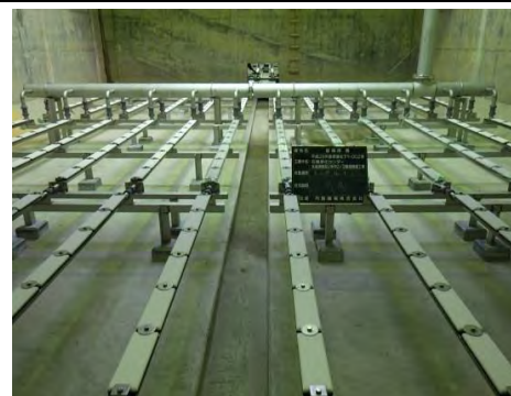
① 平成30年3月 現在 水処理施設 2系列 2 / 2 工事完了後
