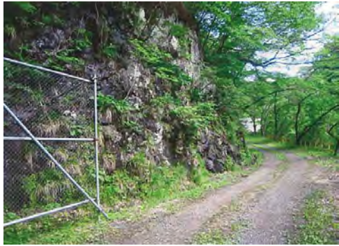
① 花山ダム 栗原市花山字本沢向原地内 花山ダム管理用道路仮設防護柵設置
