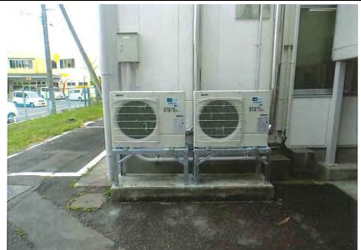
④ 平成29年9月15日 完成
