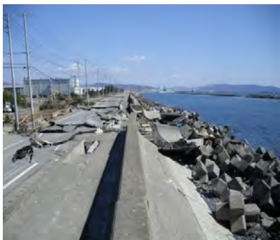
⑤平成26年9月19日着工 西浜防潮堤災害復旧（その2）工事
