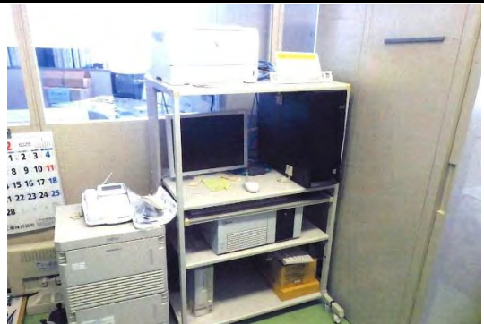
② 化女沼ダム 大崎市古川小野字遠沢地内 化女沼ダム外堤体観測装置等修繕工事
