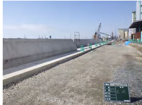
④平成30年3月26日 完成
