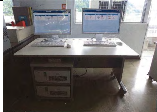
① 平成29年11月 完成
