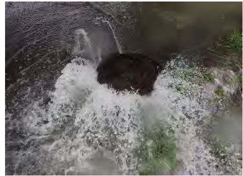
平成29年10月23日 溢水状況 (仙塩流域下水道 利府幹線 No.13 マンホール)
