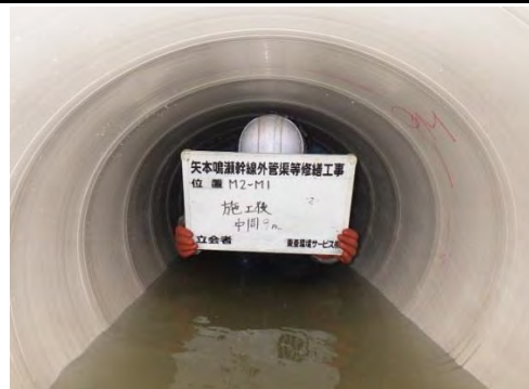
⑤ 平成29年9月 現在 管渠更生工事完了後
