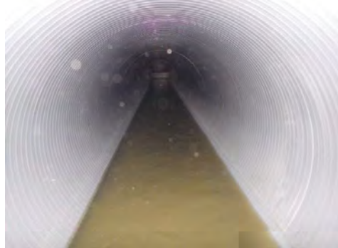
① 平成29年5月31日 管更生工事完了
