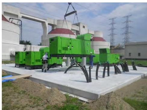
平成29年8月29日 発電施設建設状況
