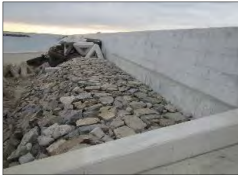
栄地区東(B, C)護岸災害復旧外工事 (仙台港区)
