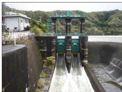
樽水ダム洪水調節 (平成 29年 10月 23日)
