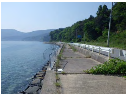
⑧平成27年2月19日着工 小島防潮堤災害復旧工事
