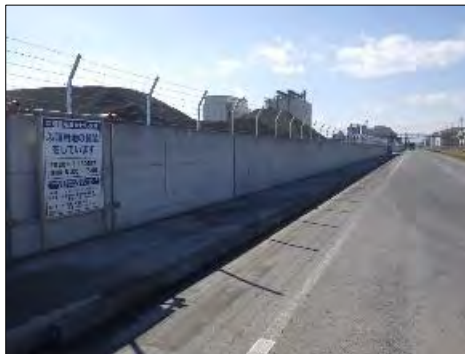
高松ふ頭防潮堤工事 (仙台港区)
