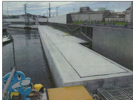
④ 平成29年8月14日 完成
