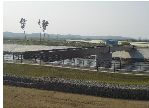
⑧ 平成29年7月 現在 完 成
