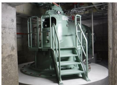
仮屋河道排水機場ポンプ増設工事
