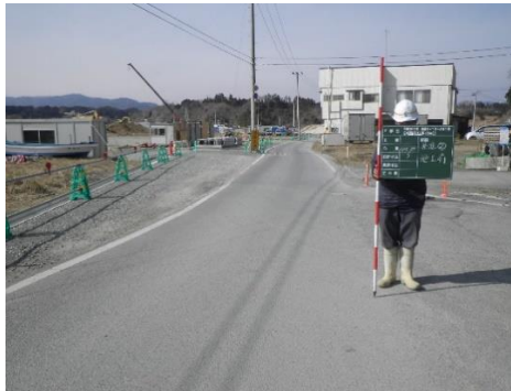
⑩(一) 泊崎半島線 本吉郡南三陸町歌津字大沼地内外 泊崎道路改良工事(その2) 着工前
