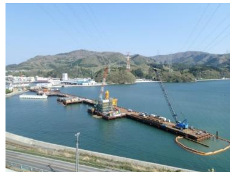
⑮ 平成30年3月 現在 着工後
