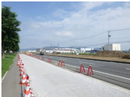
② 門脇流留線④⑤工区 (魚町) 着工前
