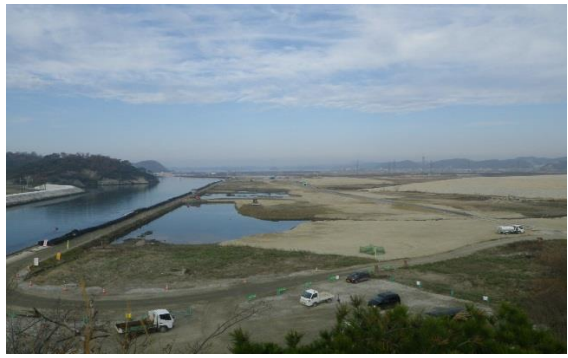
③ 東名地先海岸 東松島市大塚地内 海岸堤防復旧工事
