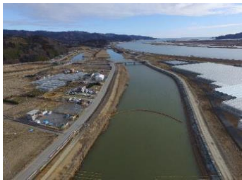
⑬311地震災第5020号 石巻市北上町橋浦 地内 皿貝川 河川堤防沈下
