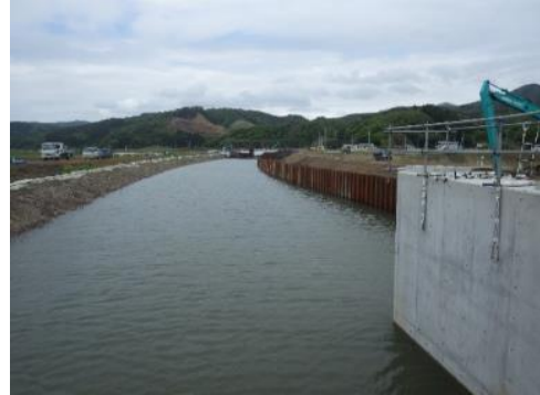
⑫ 平成30年3月 現在 本復旧 施工中
