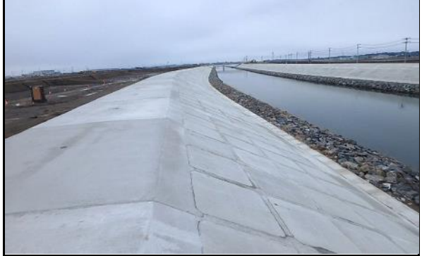
⑨ 平成30年3月 現在 法覆護岸工 完了
