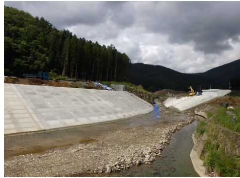
⑫ 平成30年3月 現在 本工事（下部工）施工中
