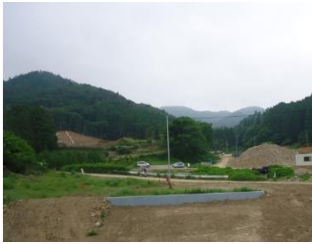
⑬ 国398号 女川町御前浜地内 着工前
