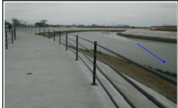
⑧ 平成30年3月 現在 法覆護岸工 完了
