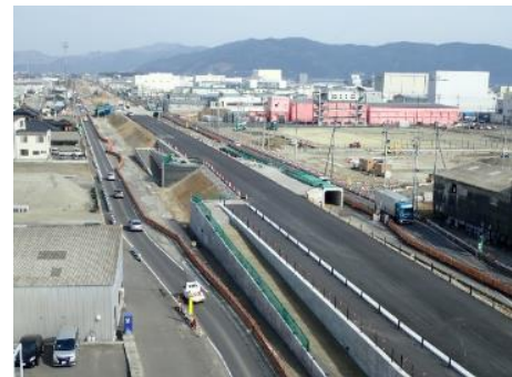
② 平成30年3月 現在 施工中
