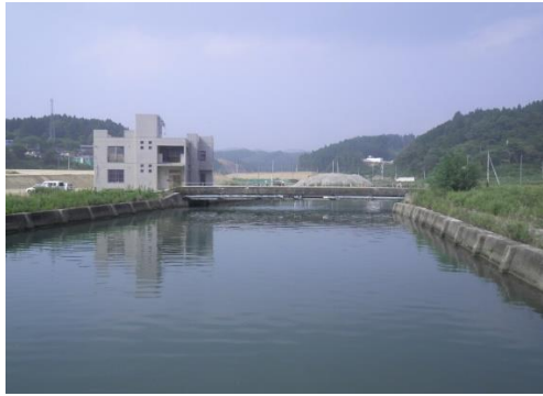
③新井田川 南三陸町志津川字本浜町地内 河川堤防沈下欠壊
