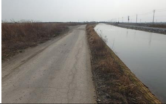
⑨ 南北上運河 東松島市大曲地内 着工前
