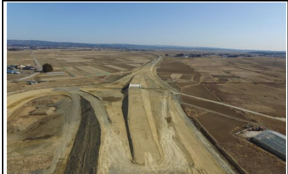
④ 平成30年3月 現在 盛土施工中
