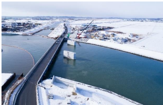
⑦ (一) 石巻工業港矢本線 石巻市門脇地内 定川大橋橋梁災害復旧工事
