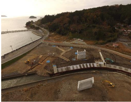
⑥ (主) 石巻鮎川線 石巻市十八成浜地内 十八成浜復興道路
