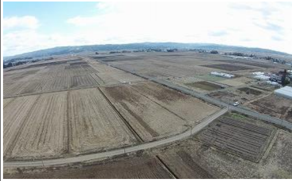
③ 登米市中田町宝江新井田地内 みやぎ県北高速幹線道路Ⅱ期（中田工区）
