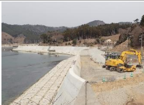
⑤ 平成30年3月 現在 本復旧 施工中
