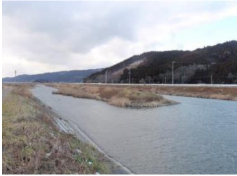
⑭ 311地震災第5020号 石巻市大網 地内 中島川 河川堤防沈下
