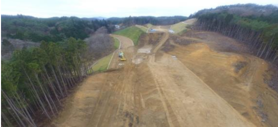
⑦ 平成27年12月5日 本線部施工状況 宮城県本吉郡南三陸町歌津字白山地内
