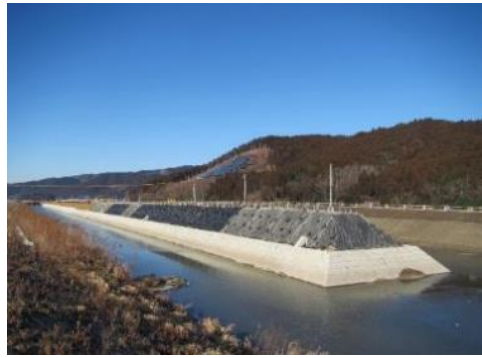
⑭ 平成30年3月 現在 本復旧 施工中
