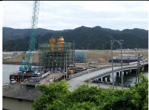
⑨ 平成30年3月 現在 本復旧（下部工） 施工中
