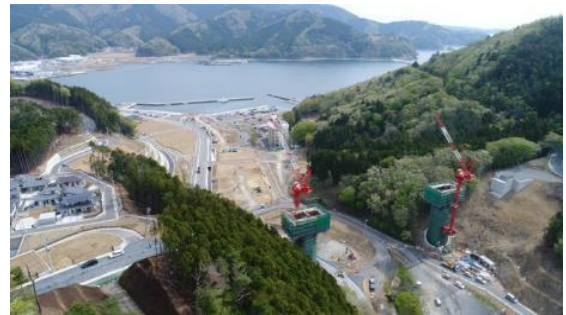
⑭ 平成30年3月 現在 着工後
