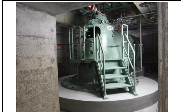
② 平成30年3月現在 完成
