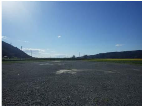
① 国道398号 大瓜工区 着工前
