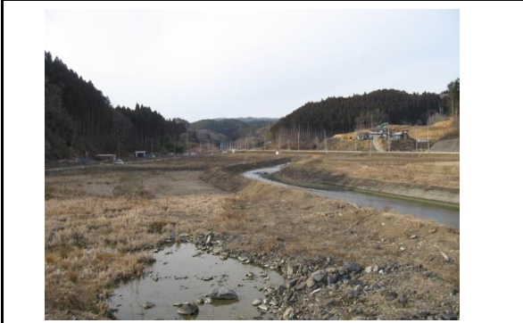
② 桜川 南三陸町志津川字松井田地内 河川堤防沈下欠壊
