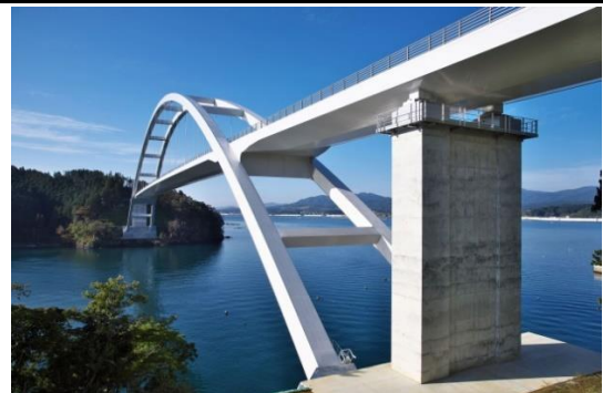
④平成29年10月17日 工事完成
