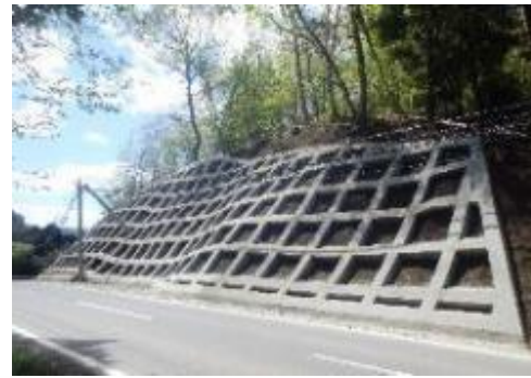
⑪ 平成29年12月 現在 完成
