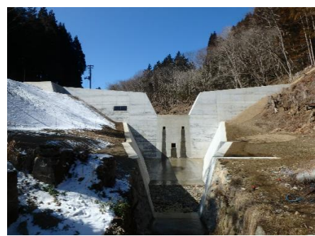
⑪ 平成30年2月23日 現在 緊急改築 完了
