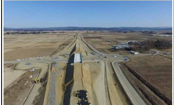
③ 平成30年3月 現在 盛土施工中
