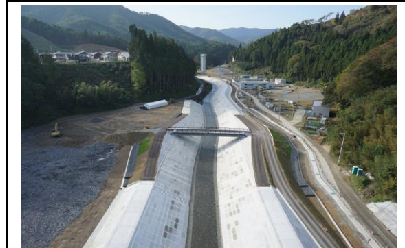
① 平成29年10月23日 上流区間完成
