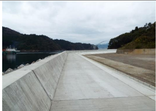
⑧ 平成29年10月23日 完成
