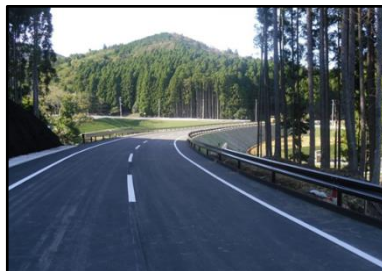
【(国)398号・御前浜工区】
