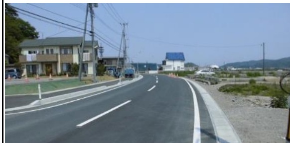
④ 平成28年6月 完成
