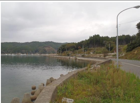
⑤ 清水田地区海岸 石巻市清水田浜地先外 海岸堤防復旧工事
