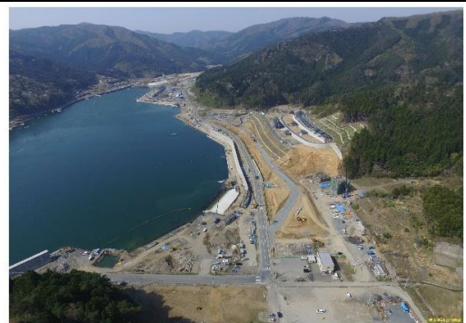
⑪ 平成30年3月 現在 本工事 施工中
