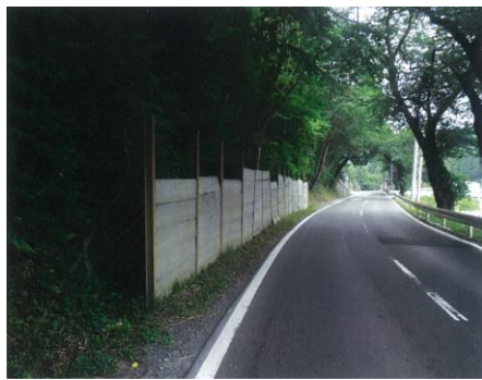
⑫ 桐ヶ崎地区 牡鹿郡女川町桐ヶ崎地内 道路法面对策
