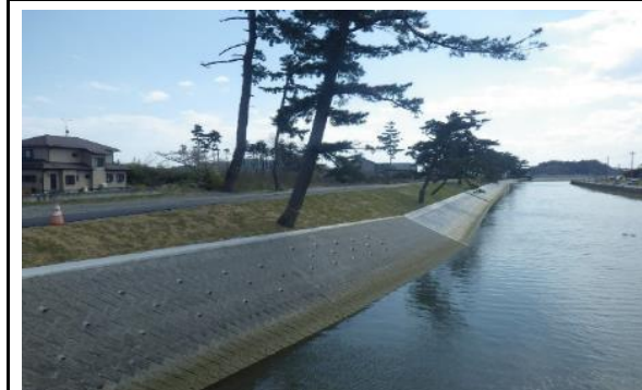
② 平成30年3月 現在 本復旧 施工中
