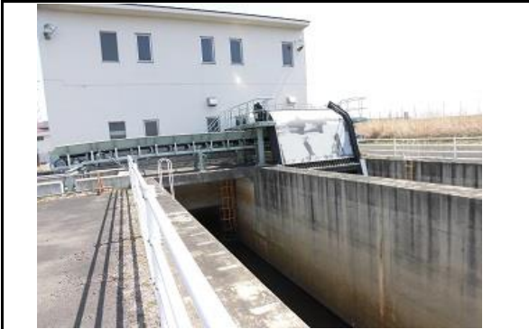
① 登米市迫町北方字仮屋地内 迫川(荒川)河川改修 仮屋河道排水機場 除塵機整備
