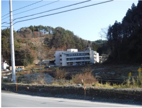
③ (一) 大島浪板線 気仙沼市浪板地内 浪板道路改良工事
