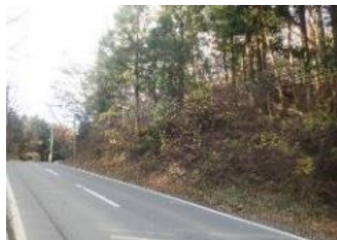
⑪ 竹浦地区 牡鹿郡女川町竹浦地内 道路法面对策
