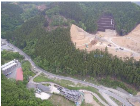
⑭ 女川牡鹿線 女川町小乗浜地内 着工前
