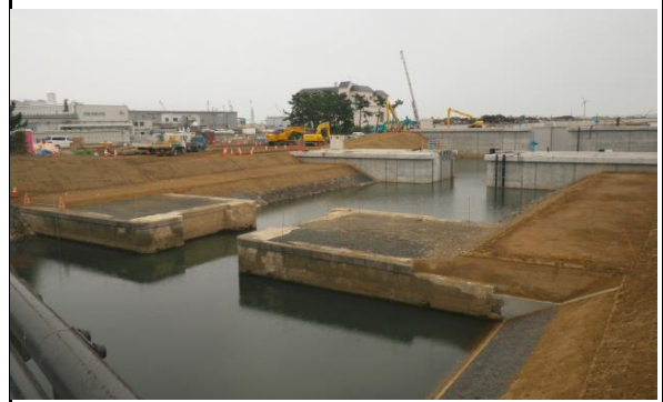
⑥ 平成30年3月 現在 法覆護岸工施工中
