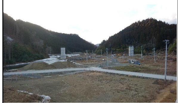
⑩ 平成30年3月 現在 本復旧 施工中
