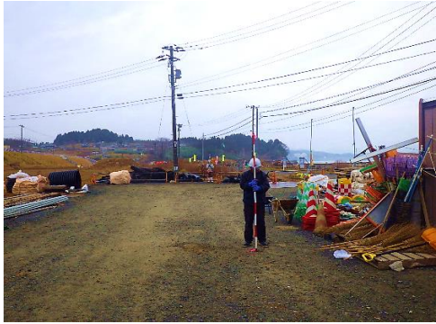
⑫(国)398号 本吉郡南三陸町戸倉字波伝谷地内外 波伝谷道路災害復旧外工事 着工前
