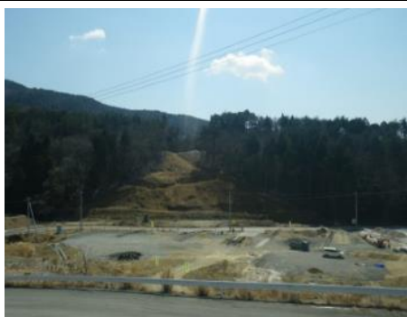
⑤ (主) 石巻鮎川線 石巻市小網倉浜地内 小網倉浜復興道路
