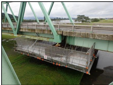
【神取橋耐震補強】
