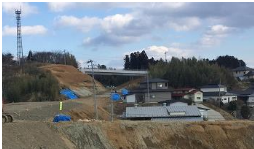
錦織バイパス工事（平成 30 年 3 月現在）
