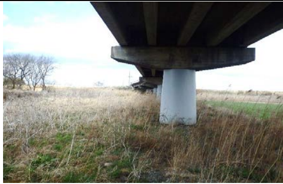
⑧ 登米市米山町中津山字三方江地内 二ツ屋橋外橋梁耐震補強工事（三ツ口橋）
