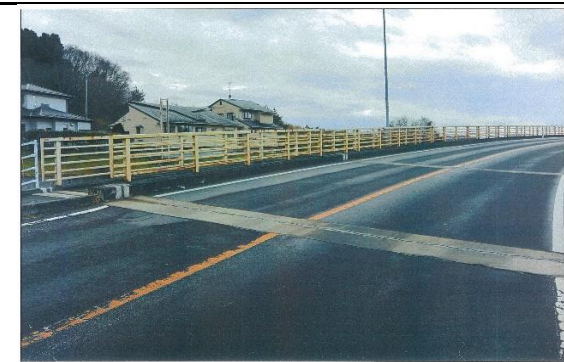
⑥ 登米市迫町新田地内 新田跨線橋橋梁補修工事(その2)
