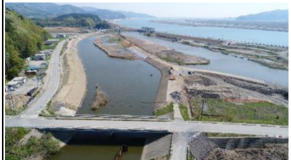
⑮ 平成30年3月 現在 本復旧 施工中
