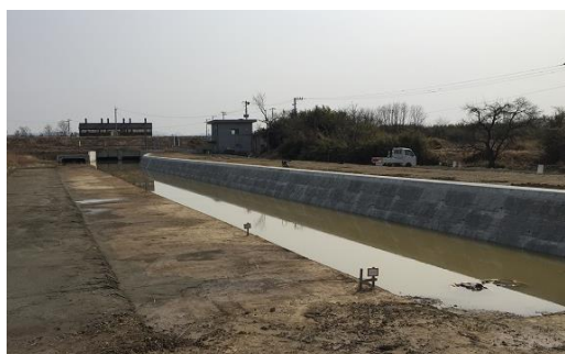
長沼川放水路工事 (平成 30 年 3 月現在)
