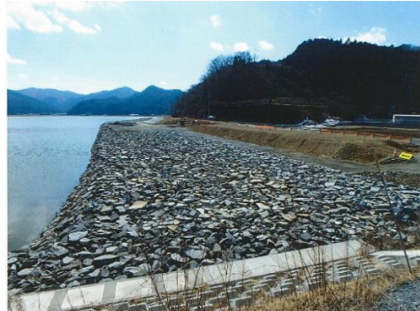
⑩ 平成30年3月 現在 施工中
