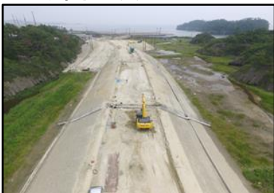
【(主)奥松島松島公園線・宮戸工区】
