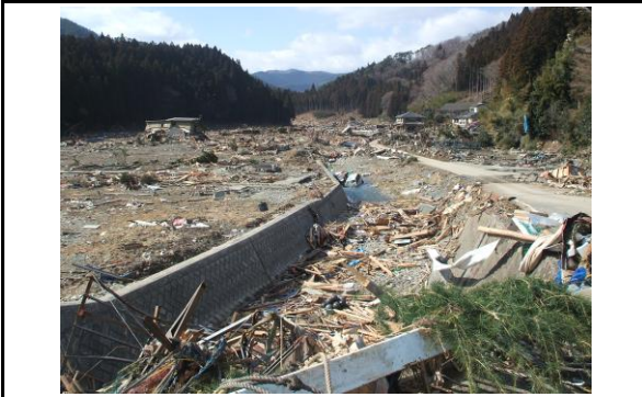
① 青野沢川 気仙沼市唐桑町 地内 河川堤防欠壊
