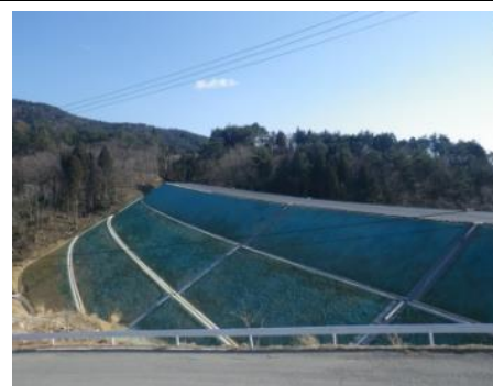
⑤ 平成30年3月 現在 1・2・3工区まで 完成
