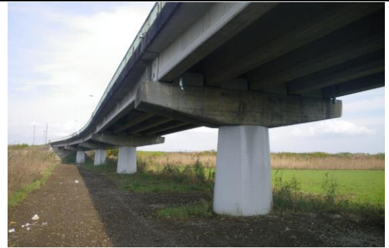
⑧ 平成30年3月現在 完成
