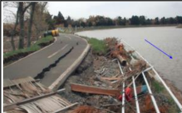
⑧ 定川 東松島市大曲字川前地内 着工前
