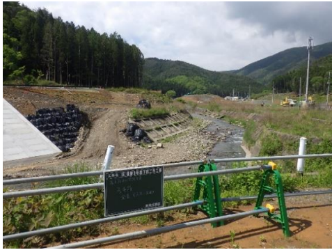
⑫ 雄勝復興道路 石巻市雄勝町雄勝地内 雄勝3号橋着工前
