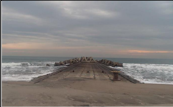
⑦ 浜市地区海岸 東松島市浜市牛網海辺地内 着工前
