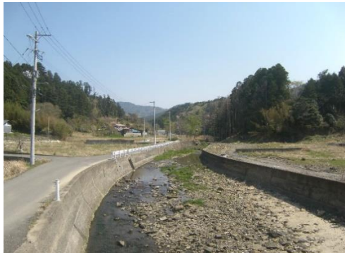
④ 淀川 石巻市十八成浜地内 河川災害復旧工事
