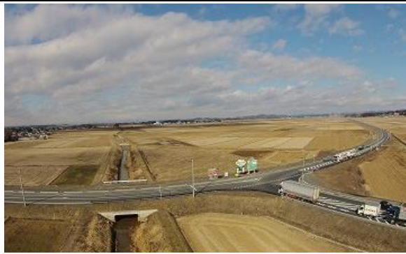
① 登米市中田町浅水地内 みやぎ県北高速幹線道路Ⅱ期（中田工区）
