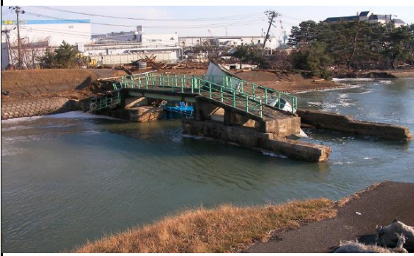
⑥ 北北上運河 石巻市門脇地内 着工前
