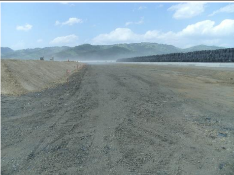
⑪ 横須賀地区海岸 石巻市長面地内 防潮堤 整備
