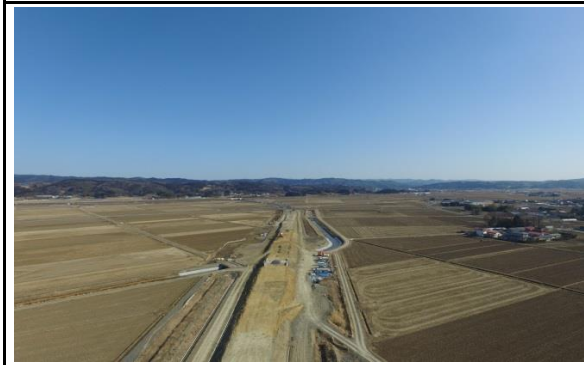
② 平成30年3月 現在 盛土施工中
