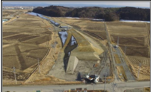
⑤ 平成30年3月 現在 盛土施工中
