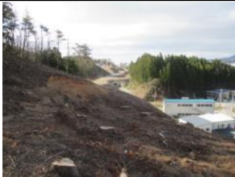
② (一) 大島浪板線 気仙沼市浪板地内 浪板道路改良工事(その2)
