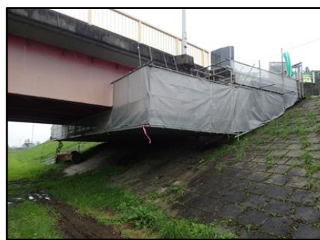
【及川橋耐震補強】
