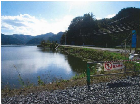
⑩ 一級河川北上川水系富士川 石巻市針岡地内 河川堤防・樋門整備
