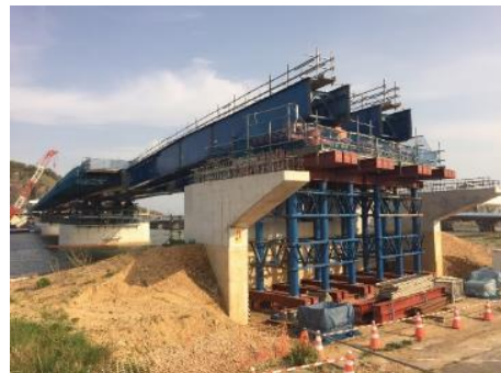
③ 平成30年3月 現在 施工中
