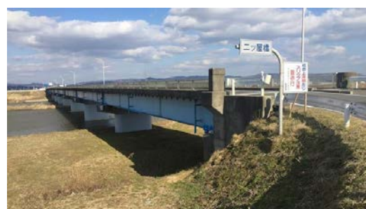
二ツ屋橋耐震補強工事（平成 30 年 3 月完成）
