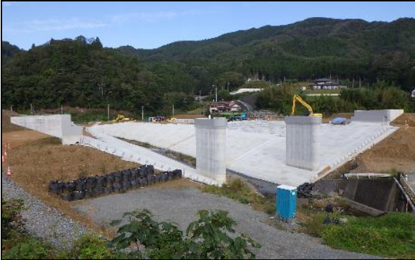
③ (一)馬場只越線 気仙沼市唐桑町只越地内外 只越橋災害復旧(上部工)工事 着工前
