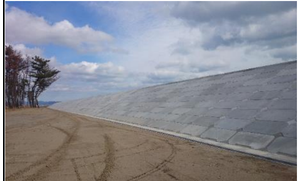
① 平成30年3月 現在 本復旧 施工中
