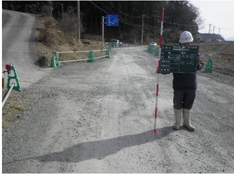
⑨(一) 泊崎半島線 本吉郡南三陸町歌津字大沼地内外 泊崎道路改良工事(その2) 着工前
