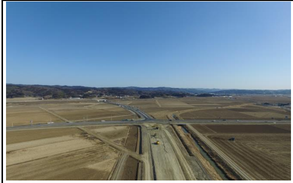
① 平成30年3月 現在 盛土施工中
