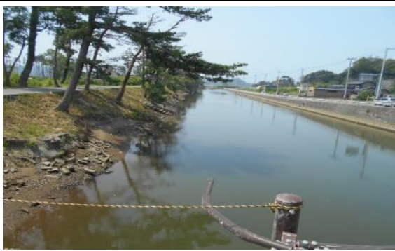
② 東名運河 東松島野蒜地内 河川災害復旧工事
