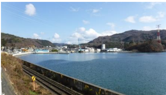
⑮ 石巻女川線 女川町浦宿地内 着工前
