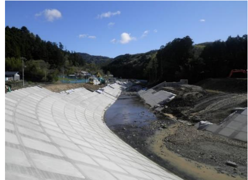
④ 平成30年3月 現在 本復旧 施工中
