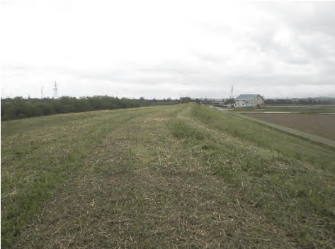
⑦ 一級河川鳴瀬川水系多田川 大崎市古川飯川地内 多田川河道掘削工事（飯川工区）
