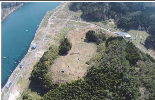
⑧ 伊勢畑復興道路 石巻市雄勝町伊勢畑地内 着工前（防集団地予定箇所）
