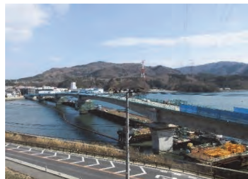
⑪ 令和3年3月 現在 上部工施工中
