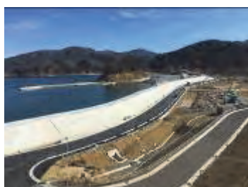
【(主)女川牡鹿線 大谷川浜道路災害復旧】
