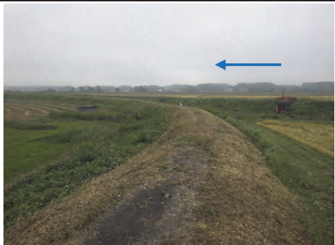
⑤ 小山田川 栗原市瀬峰筒場地内 小山田川河川改修
