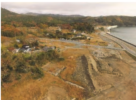
⑤ 十八成浜復興道路 石巻市十八成浜地内 着工前
