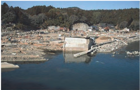
⑦ 相川復興道路 石巻市北上町十三浜字相川地内 橋梁上部工・取付道路流出状況
