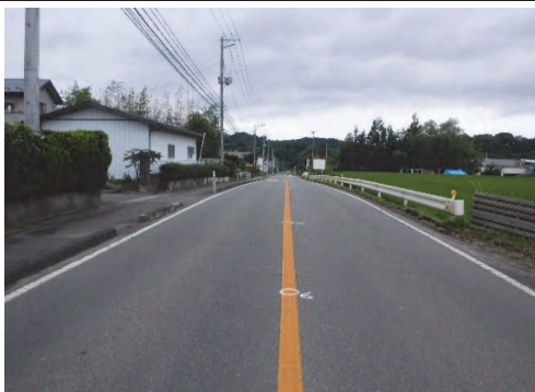
⑧ (主) 築館栗駒公園線 栗原市築館字下宮野宮当地内外 下宮野舗装補修
