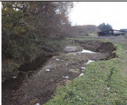
④ 一級河川北上川水系田尻川 大崎市古川宮沢地内 中雨生沢川河川災害復旧工事
