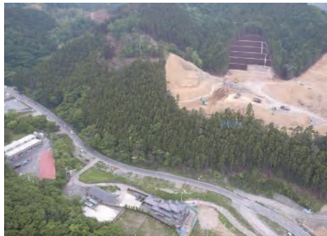
⑩ 小乗浜復興道路 牡鹿郡女川町小乗浜地内 着工前
