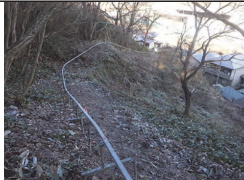
① 令和2年12月 施工中 (仮設施工中)
