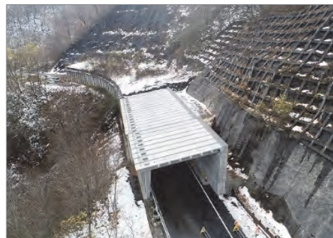
湯浜2号スノーシェッド延伸部施工状況
