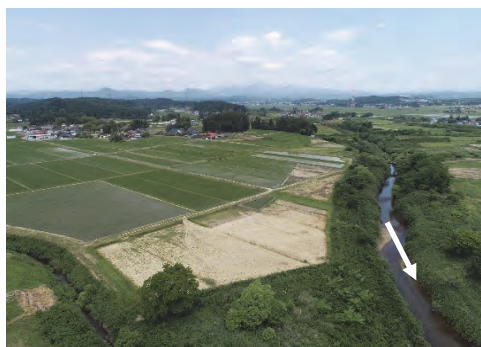
② 二迫川 栗原市栗駒泉沢八幡前地内 迫川（二迫川工区）河川改修
