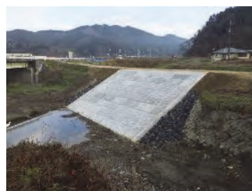
石貝川災害復旧工事 一部完成
