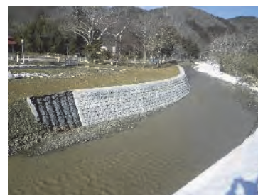
鱒淵川災害復旧工事 一部完成
