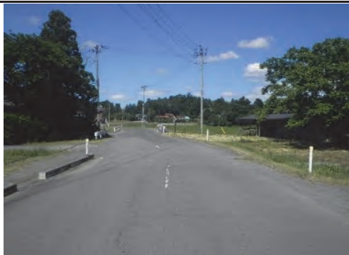
⑥ 登米市中田町石森字若林地内 （一）花泉迫線 ニツ木道路改良工事
