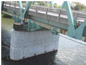
【神取橋 耐震補強工事】
