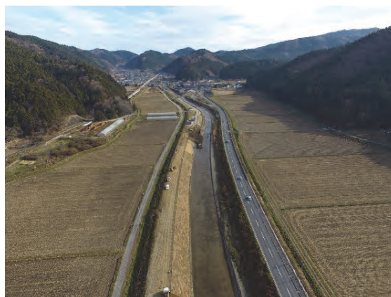
南沢川河川改修事業 施工状況 (R3.1月)
