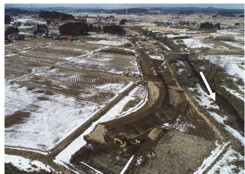
② 令和3年2月 施工中（築堤施工中）
