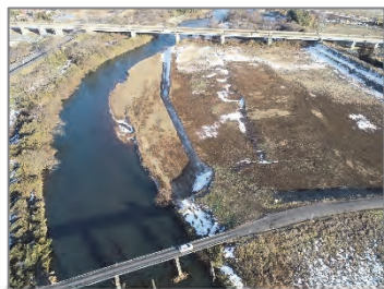
迫川(若柳大林地区)河道掘削状況
