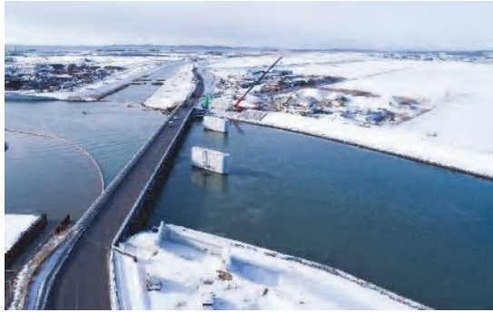
③ 定川大橋災害復旧 石巻市門脇地内 着工前
