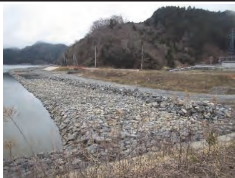
⑦ 令和 3 年 3 月 現在 施工中
