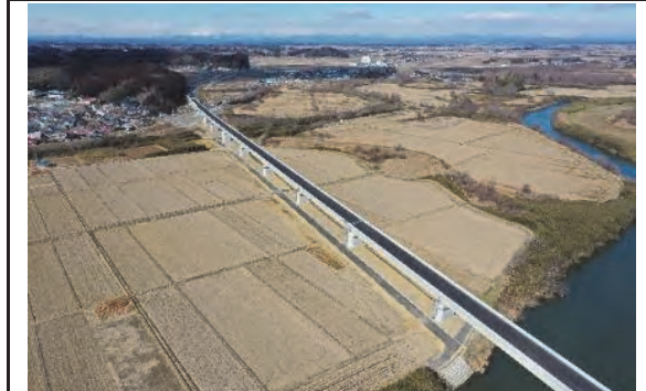
③ 令和3年3月 施工中「紫雲山大橋」
