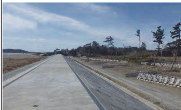
① 令和 3 年 3 月 現在 施工中
