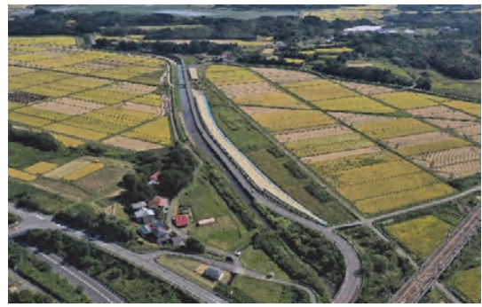
③ 令和2年 1月 施工中 (地盤改良圧密沈下促進中)
