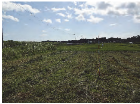
③ (主) 築館登米線 栗原市築館萩沢地内 萩沢道路改良
