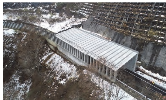
② 令和2年12月 施工中（延伸）
