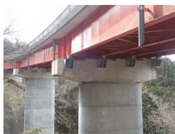
【入釜谷橋 耐震補強工事】
