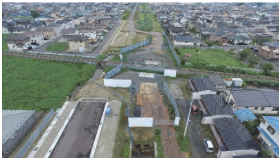
⑧ 一級河川鳴瀬川水系大江川 大崎市古川穂波地内 大江川河川改修工事（護岸）
