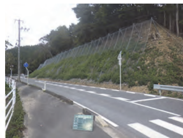
【桐ヶ崎 災害防除工事】
