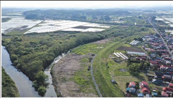
⑦ 迫川 栗原市若柳字大林地内外 支障木撤去業務
