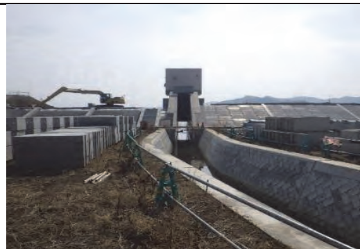
⑥ 令和 3 年 3 月 現在 施工中
