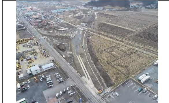
④ 令和3年3月 施工中
