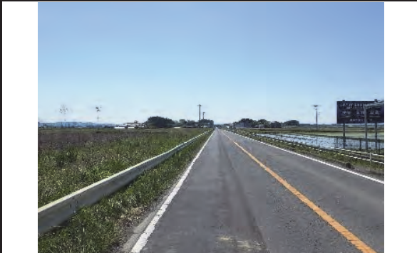
⑤ 登米市南方町後屋敷待井地内 （主）古川佐沼線 板倉自歩道設置工事
