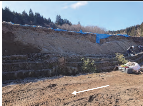
⑧ 令和3年3月 既設かご護岸撤去中
