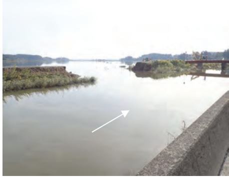
③ 荒川 栗原市築館字横須賀新曾内地内 荒川河川改修(台風19号による被災)
