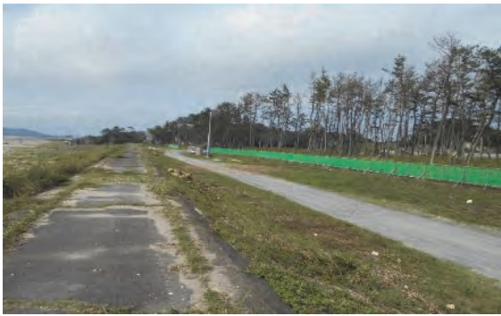
① 州崎海岸 東松島市松ヶ島地内 海岸堤防復旧工事
