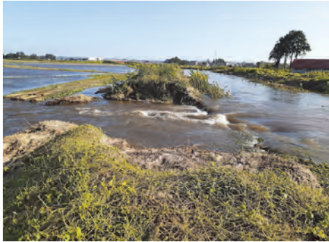
⑥ 一級河川鳴瀬川水系名蓋川 大崎市古川矢目地内 渋井川外河川災害復旧工事
