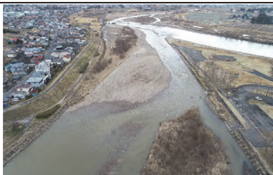
③ 一級河川鳴瀬川水系田川 田川河道掘削工事
