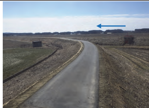
⑤ 令和3年3月 施工中（舗装完了）
