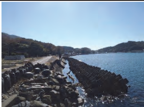
⑫ 大原地区海岸外 石巻市大原浜地先外 海岸堤防復旧工事
