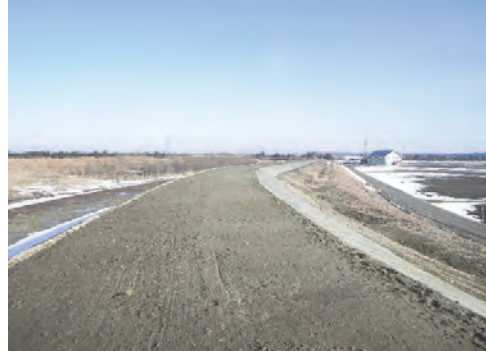
⑦ 令和3年2月18日 完成
