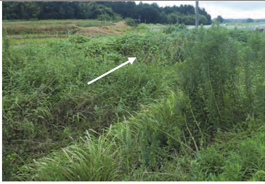
⑥ 熊谷川 栗原市志波姫間内東地内外 堆積土砂撤去工事
