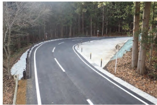
④ 令和2年12月 施工中 (道路拡幅部分完了)
