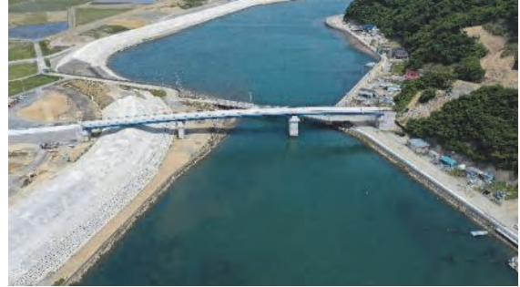
⑥ 令和3年3月 現在 本復旧（上部工） 完成
