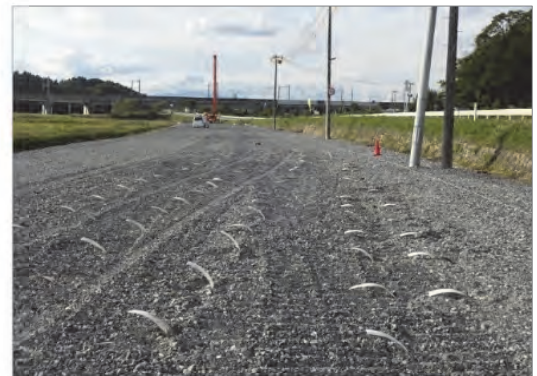
築堤工(地盤改良)の施工状況
