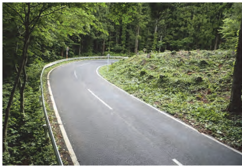
④ 国道398号 栗原市花山温泉地内 温泉道路改良
