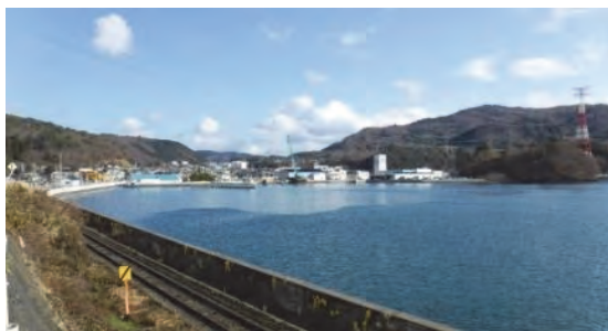
⑪ 浦宿BP 牡鹿郡女川町浦宿浜地内 着工前
