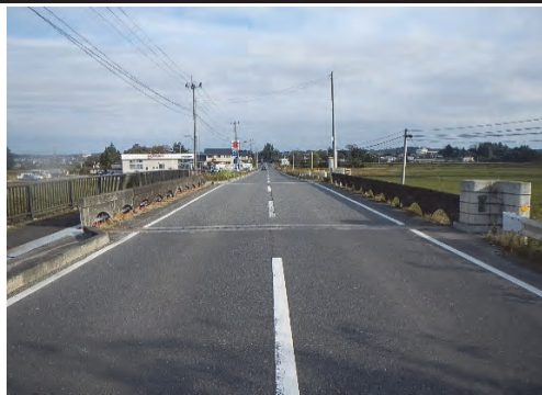
⑦ (主) 古川佐沼線 栗原市清水字台町地内外 透川橋橋梁補修
