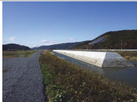
⑪ 令和3年3月 現在 本復旧 施工中
