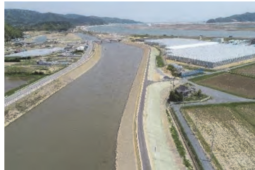
⑩ 令和3年3月 現在 本復旧 施工中
