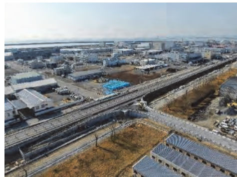
① 令和3年3月 現在 (交差点・側道部施工中)
