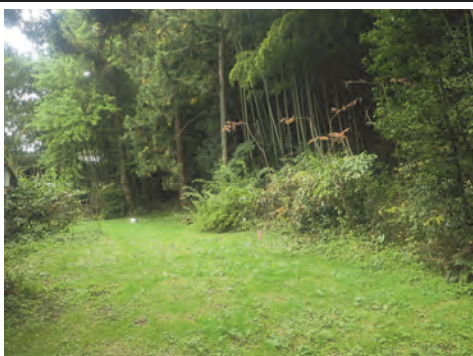
② 川口 栗原市一迫川口地内 川口急傾斜地崩壊対策
