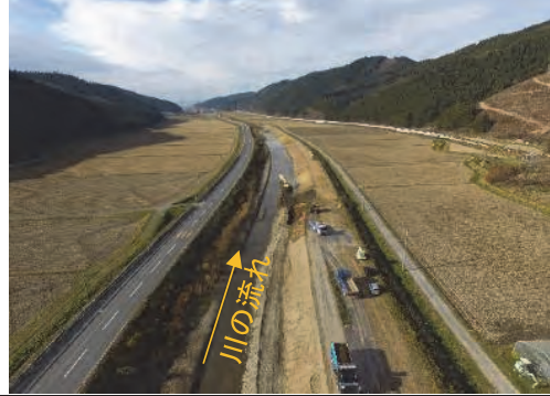
③南沢川 登米市津山町横山字南沢地内 南沢川改修工事（上流側より）令和3年1月
