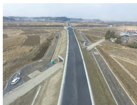
佐沼工区 施工状況 (R3.3月)
