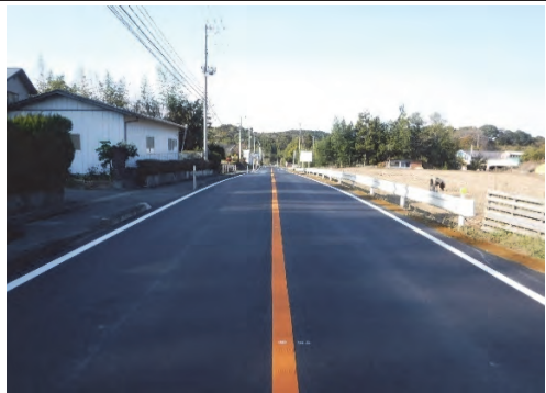
⑧ 令和2年11月 完成
