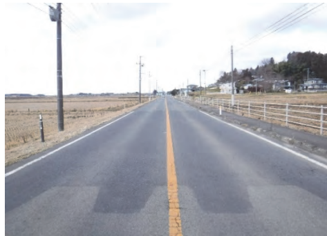
⑥ (主) 古川佐沼線 栗原市瀬峰上富前地内外 上富前舗装補修
