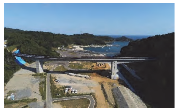
⑦ 令和3年3月 現在 本工事施工中（相川1号橋周辺）
