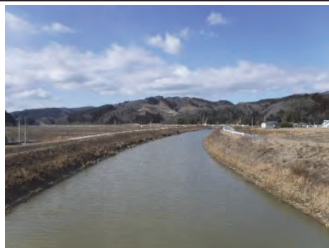
⑨ 令和3年3月 現在 本復旧 施工中
