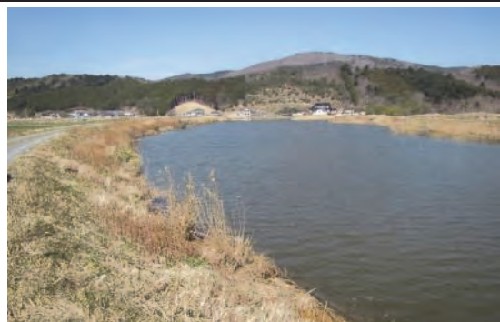
③ 真野川 石巻市大瓜地内 河川堤防復旧工事
