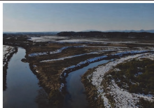
⑦ 令和3年1月 施工中
