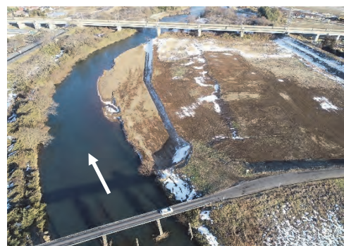
① 令和3年2月 完了（河道掘削完了）
