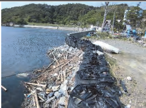
⑬ 長石地先海岸 東松島市大塚長石 地内 海岸堤防復旧工事
