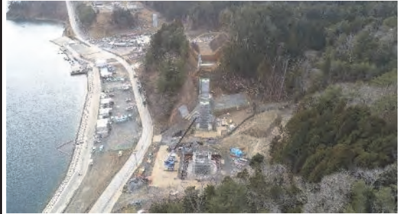
⑨ 令和3年3月 現在 本工事施工中
