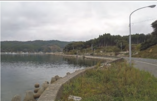
⑤ 清水田地区海岸外 石巻市清水田浜地先外 海岸堤防復旧工事
