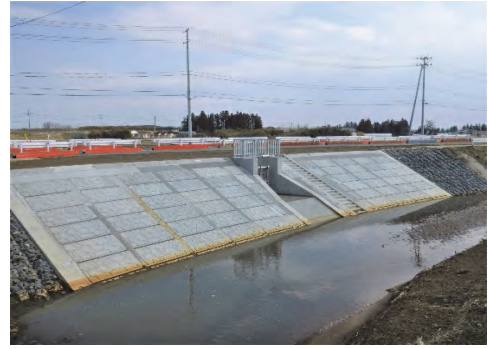
① 令和3年3月 施工中（排水樋管完成）
