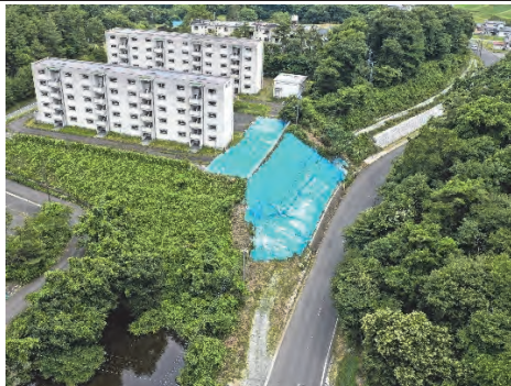
⑤ (主) 河南築館線 栗原市築館萩沢土橋地内 萩沢土橋交通安全施設整備
