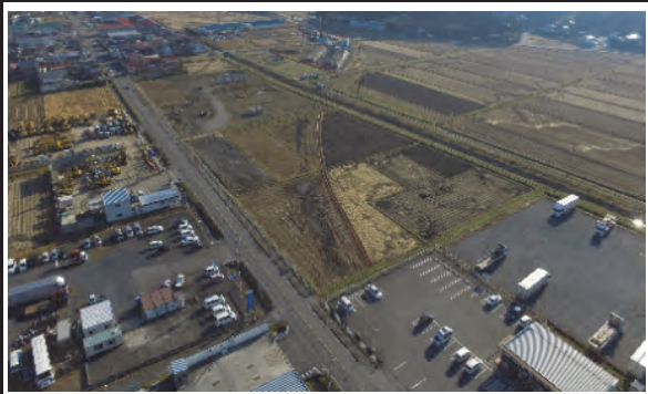
④ みやぎ県北高速幹線道路Ⅲ期（佐沼工区） 起点部 平成29年2月
