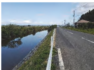
荒川災害復旧工事 一部完成
