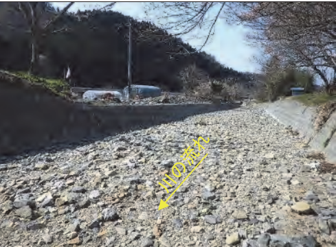
⑤北沢川 登米市津山町横山字宮田地内 北沢川河川災害復旧工事
