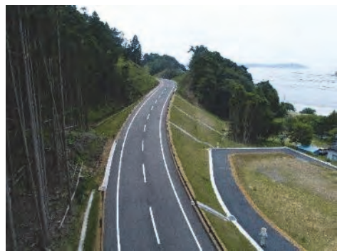
④ 令和元年7月9日 完成
