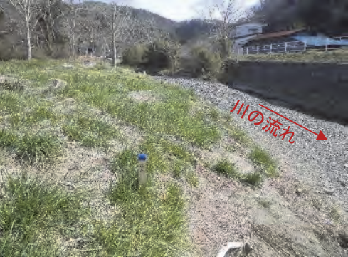
④鱒淵川 登米市東和町米川字城ノ内地内 鱒淵川河川災害復旧工事
