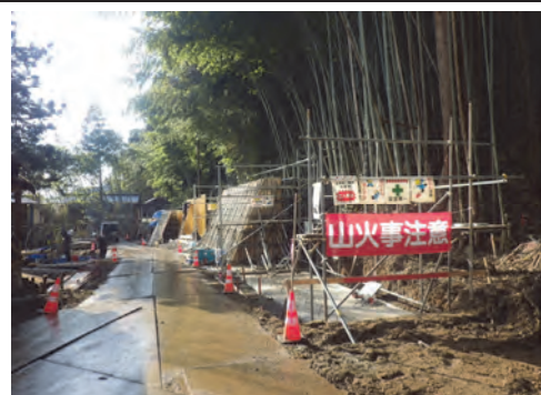
② 令和3年3月 施工中 (型枠組立作業中)
