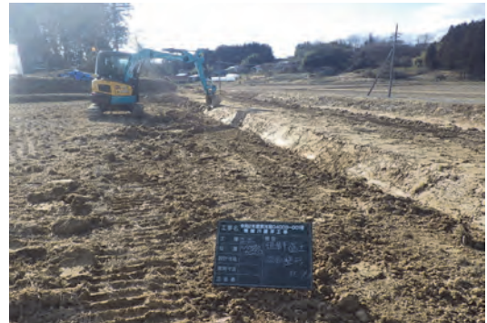
④ 令和2年3月 施工中（畦畔設置）
