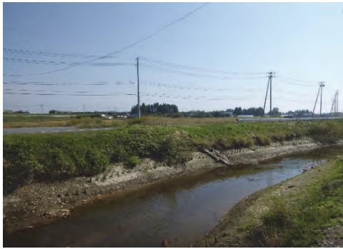
① (一) 若柳築館線 栗原市若柳川南地内 川南道路改良
