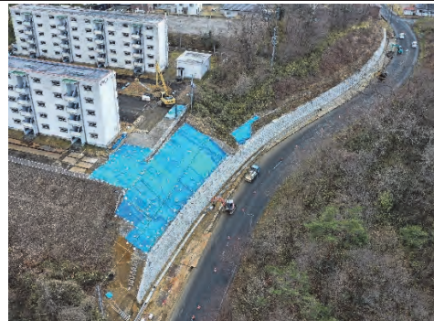
⑤ 令和元年12月 施工中 (擁壁工施工中)
