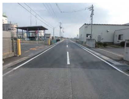
仙台塩釜港(石巻港区) 臨港道路北一号線外
