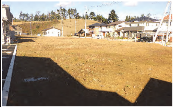
③令和元年11月13日 着工 南三陸警察署待機宿舎等新築工事 南三陸町
