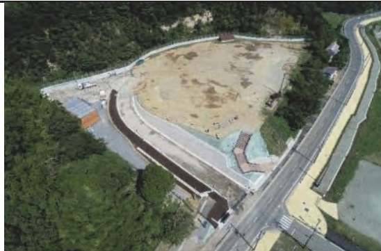
⑦令和元年6月19日 着工 松島自然の家改築工事（第二期） 東松島市
