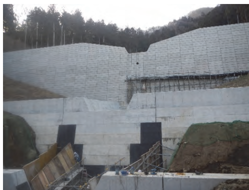
南台沢(白石市) ※施工中
