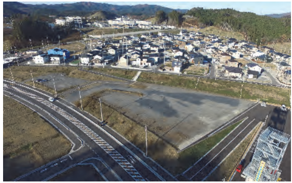
⑥令和元年11月28日 着工 南三陸警察署庁舎等新築工事 南三陸町
