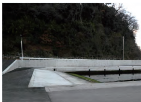
仙台塩釜港(塩釜港区) 代ヶ崎船だまり(A)船揚場
