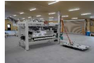
▲廃太陽光パネルの処理設備
