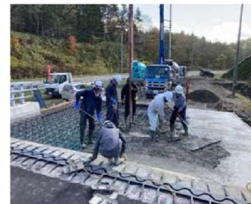
コンクリート打設作業状況
