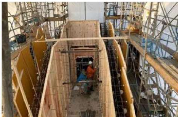
組立・設置作業状況
