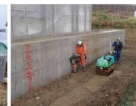
締固め作業状況
