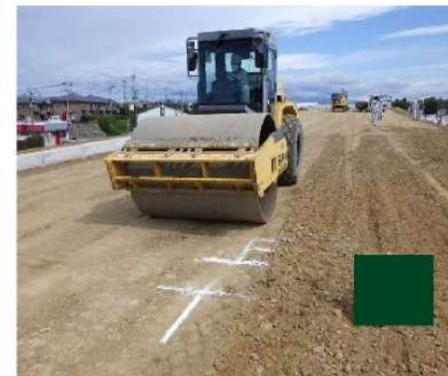
締固め作業状況
