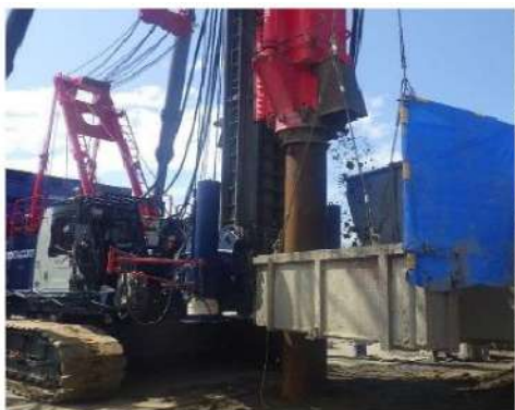
杭打作業状況
