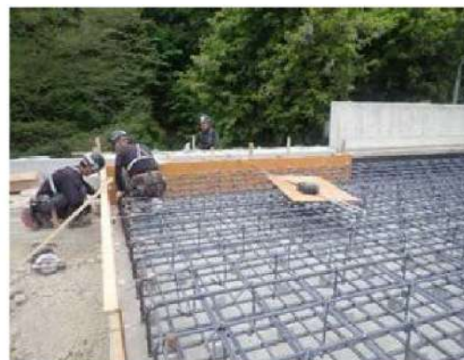
型枠設置作業状況
