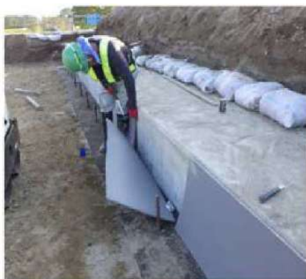
目地板設置作業状況
