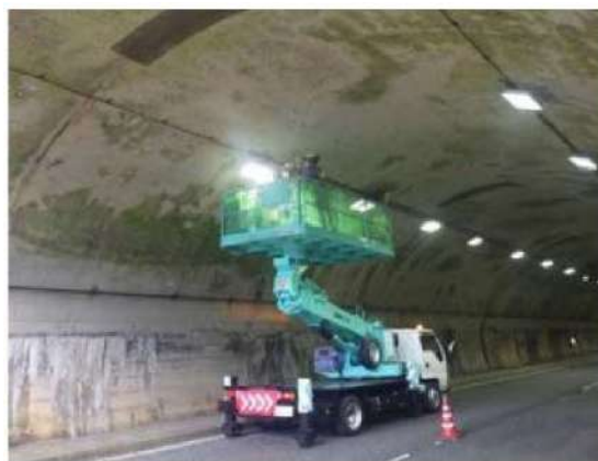
人力施工状況高所作業車(トラック架装) 伸縮ブーム・プラットフォーム型
