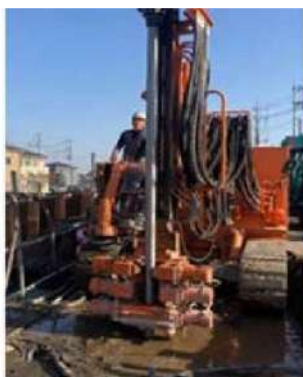
二重管ダブルパッカー工法 削孔作業状況
