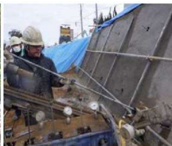
アンカー鋼材挿入作業状況
