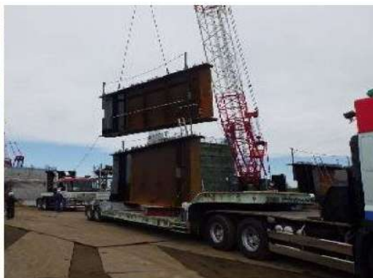
鋼桁現場取卸作業状況 (吊作業)
