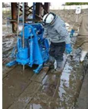
二重管ストレナーナ工法 (複相) 施工状況
