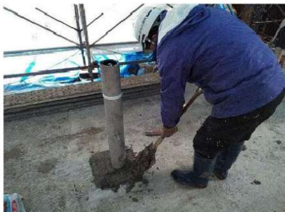
間詰コンクリート打設作業状況
