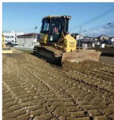
敷均し作業状況
