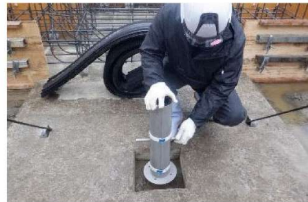
グラウト管設置作業状況（箱抜き後設置・間詰有）
