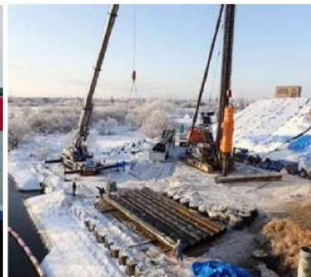
鋼管杭現場取卸作業状況 (施工ヤード)
