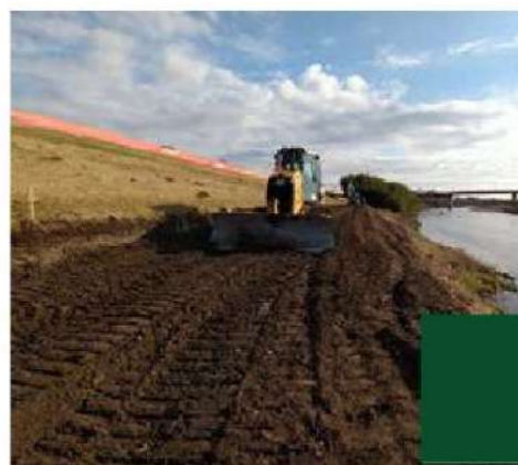
敷均し作業状況
