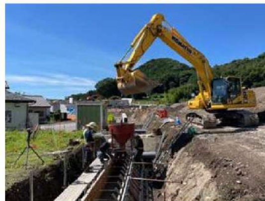
コンクリート打設作業状況 (クレーン機能付きバックハウ)
