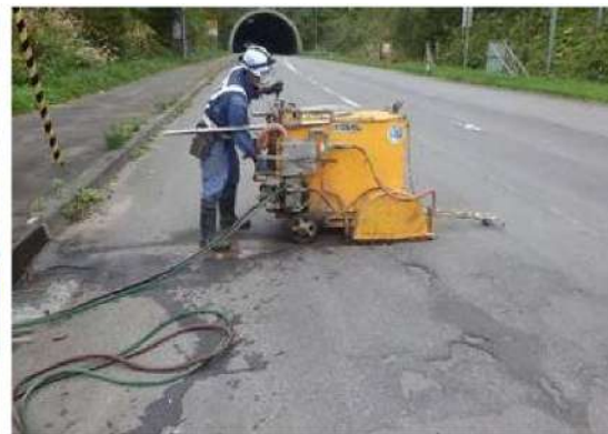
舗装版切断作業状況
