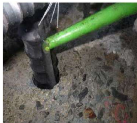
アンカー定着作業状況
