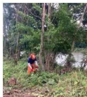
伐木作業状況 (人力施工)
