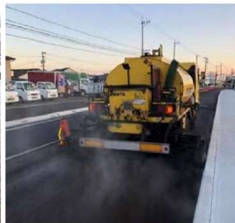
瀝青材料散布作業状況
