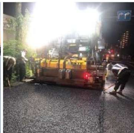
敷均し作業状況
