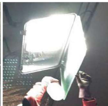
人力施工状況 (内面清掃)
