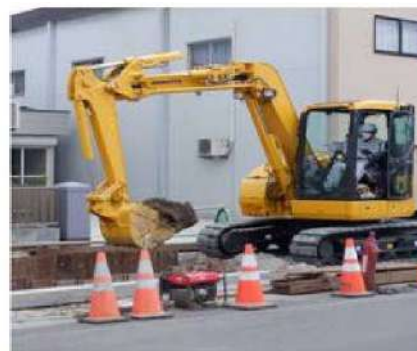
床掘り作業状況
