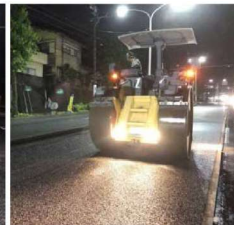
締固め作業状況
