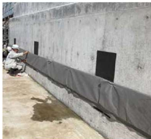
排水材設置作業状況 (接着剤)
