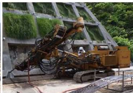
削孔作業状況 (クローラ型)
