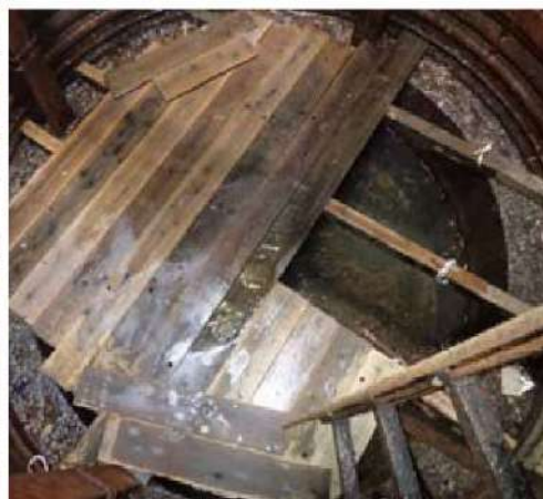
足場設置・撤去作業状況
