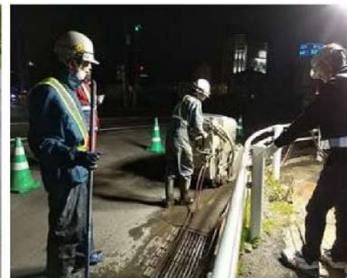
舗装版切断作業状況
