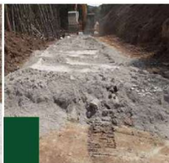
敷均し作業状況
