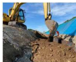
敷均し作業状況
