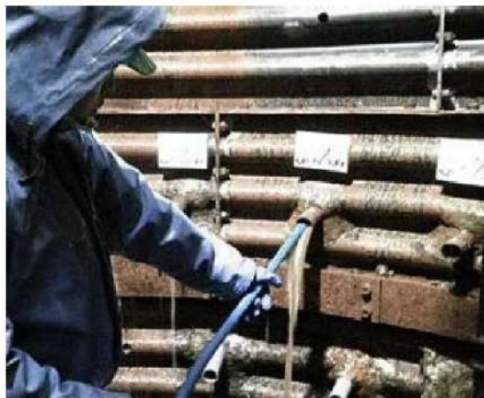
孔内洗浄作業状況 (井内作業)
