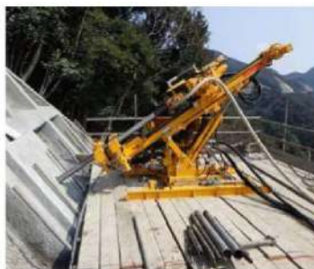
削孔作業状況 (スキッド型)
