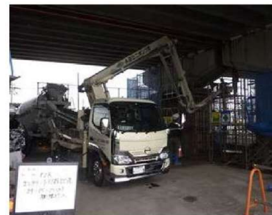
コンクリート打設作業状況
