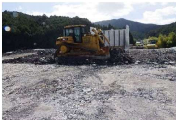
敷均し作業状況
