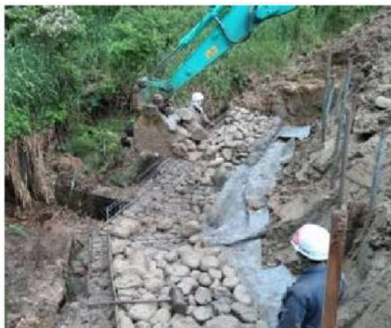
詰石作業状況
