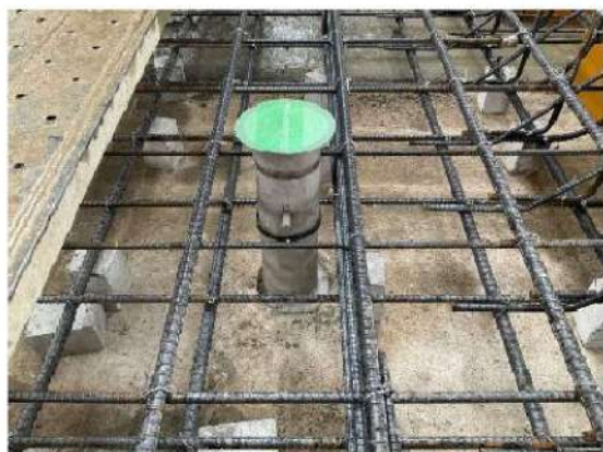
沈下板・グラウト管設置作業状況
