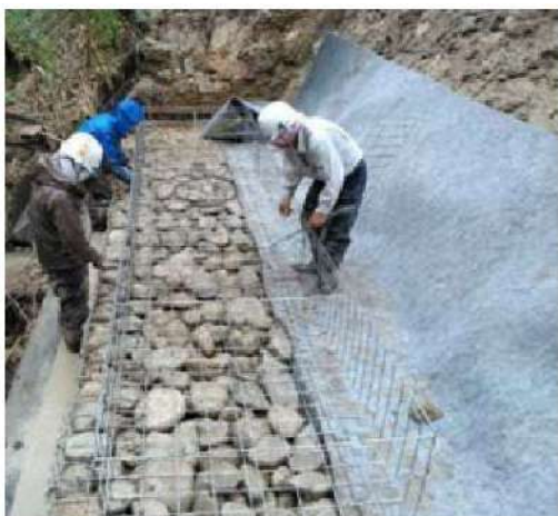
かご組立・据付け作業状況
