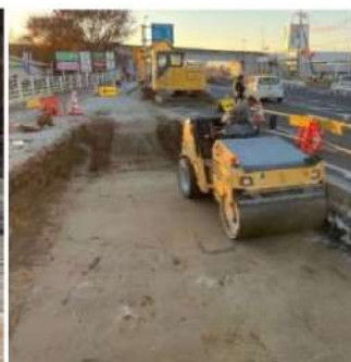
締固め作業状況
