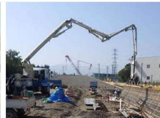
コンクリート打設作業状況 (コンクリートポンプ車)
