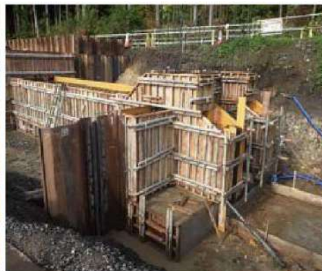
型枠設置完了状況
