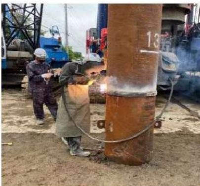
継手溶接作業状況
