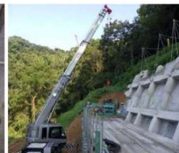
ボーリングマシン移設作業状況
