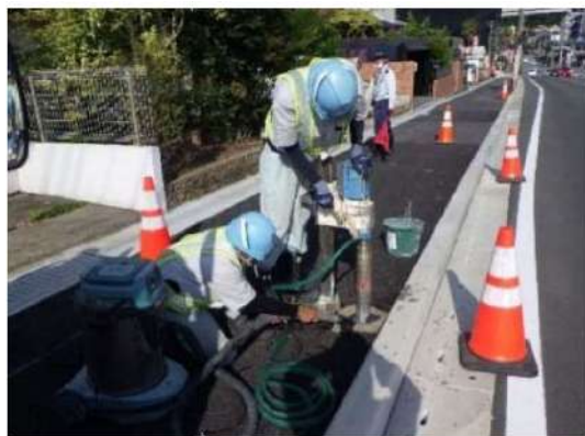
削孔作業状況
