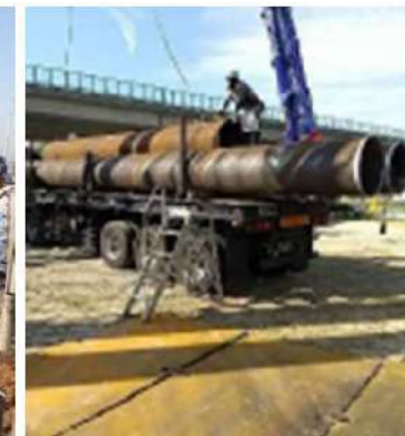
鋼管杭現場取卸作業状況 (玉掛作業)
