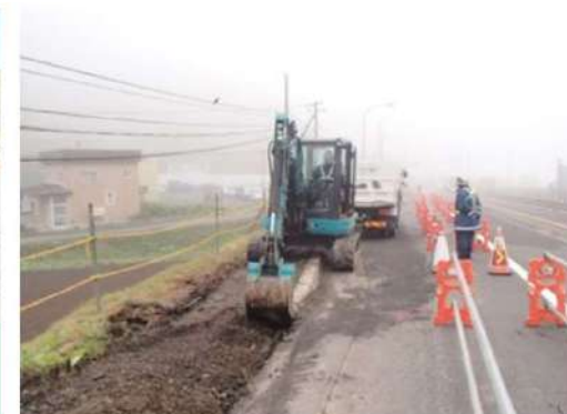
ブロック取外し作業状況
