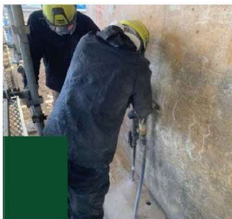
コンクリート削孔作業状況
