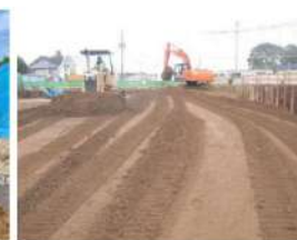
締固め作業状況
