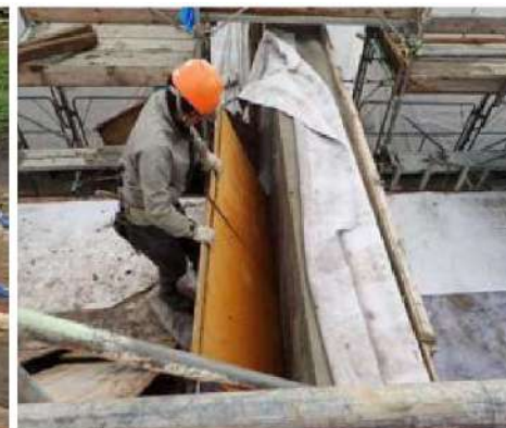
解体・撤去作業状況
