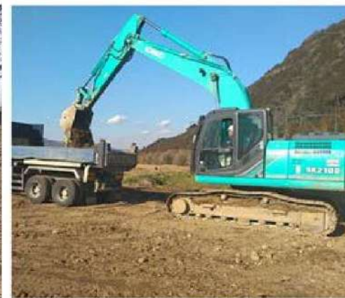
掘削積込作業状況
