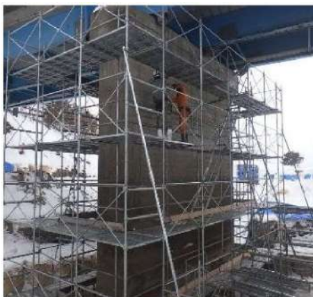
足場設置作業状況
