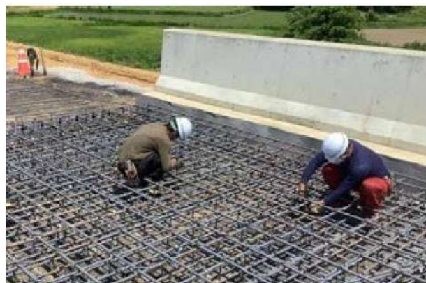
鉄筋組立作業状況
