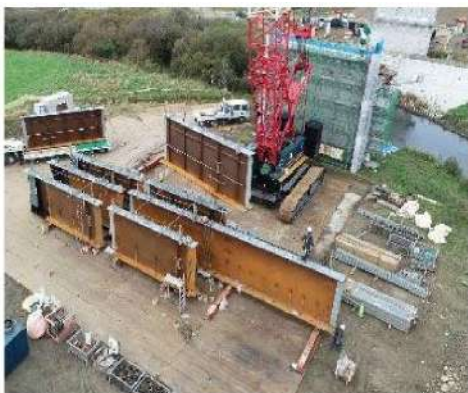
鋼桁現場取卸作業状況 (施工ヤード)
