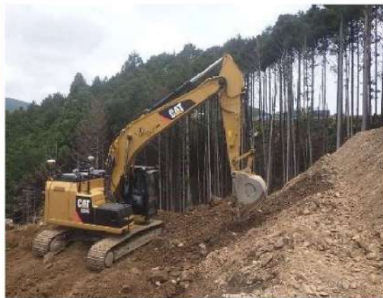
掘削作業状況
