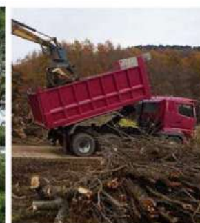
運搬作業状況 (土砂禁止用ダンプトラック)
