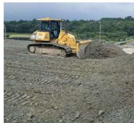
敷均し作業状況
