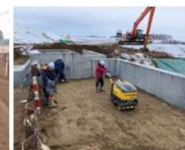
締固め作業状況
