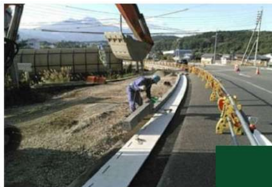
ブロック敷設作業状況
