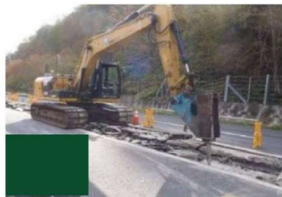
舗装版破碎作業状況
