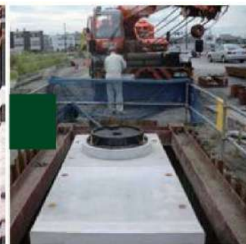
蓋設置作業状況
