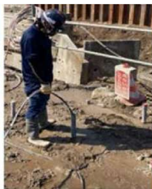
二重管ダブルパッカー工法 注入作業状況
