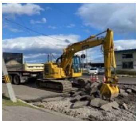
直接掘削・積込作業状況
