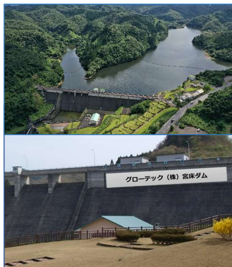
宮床ダム（全景・導入イメージ）
