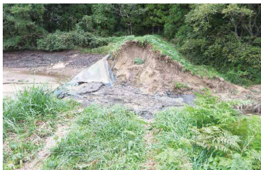
決壊した農業用ため池(白石市)
