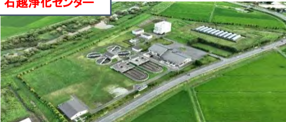
迫川流域下水道 石越浄化センター
