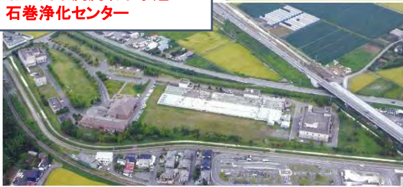
北上川下流流域下水道 石巻浄化センター
