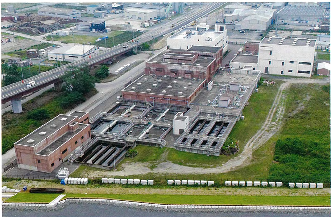
石巻東部浄化センター全景
