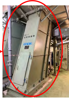
No.1自動除塵機外観 No.1自動除塵機内部
