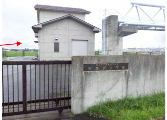
矢本ポンプ場 建屋
