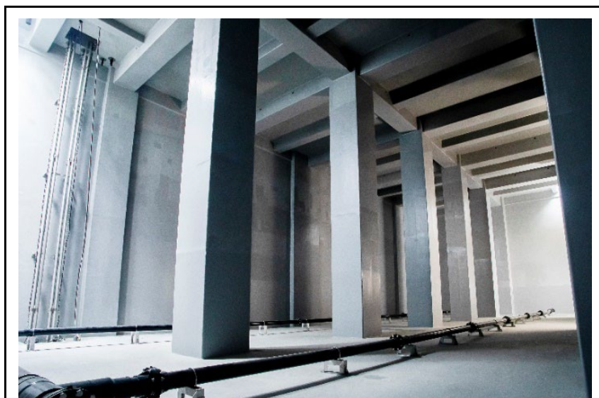
浸出水調整槽（覆蓋式）の内部
