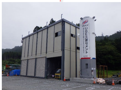
▲仮設プラント設置
