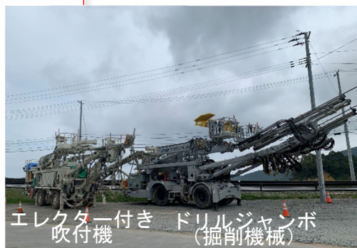
▲トンネル機械
