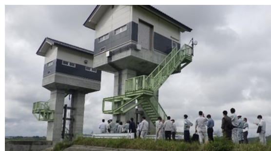
現地（砂原水門）
