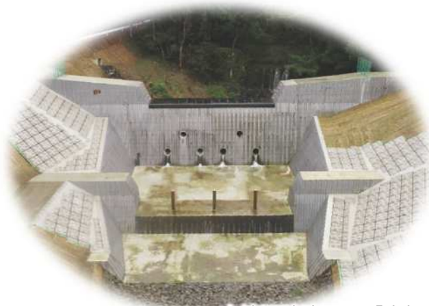
山崎沢砂防堰堤 [東松島市]
