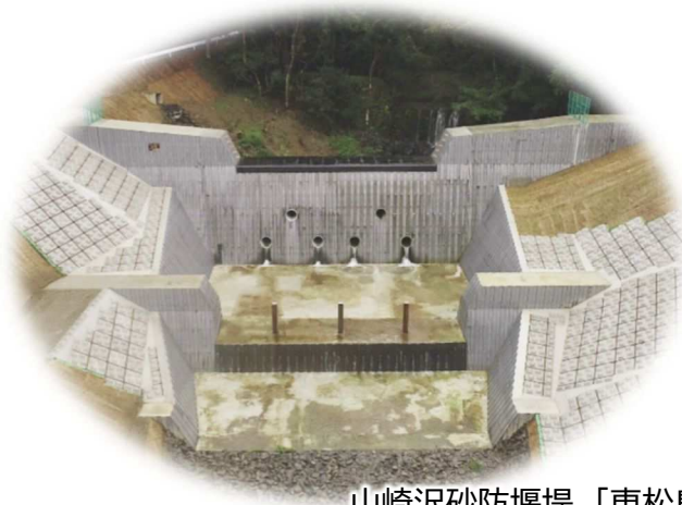
山崎沢砂防堰堤 [東松島市]
