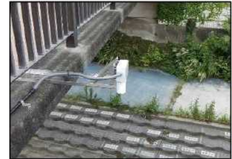
水位計の整備、改良
