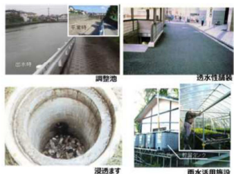
雨水貯留浸透施設の例
