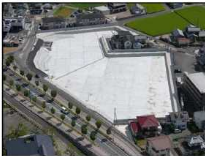
雨水貯留浸透施設の整備、改良
