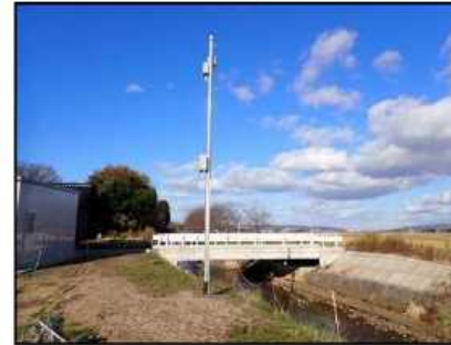
河川監視カメラの整備、改良
