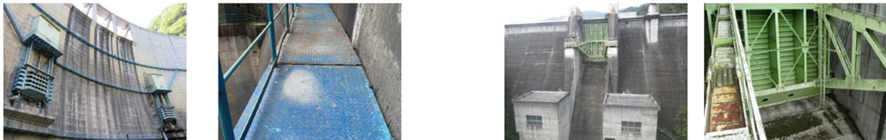
ダム管理用通路の改修(塗装)
