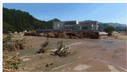
平成28年台風第10号による被害状況
