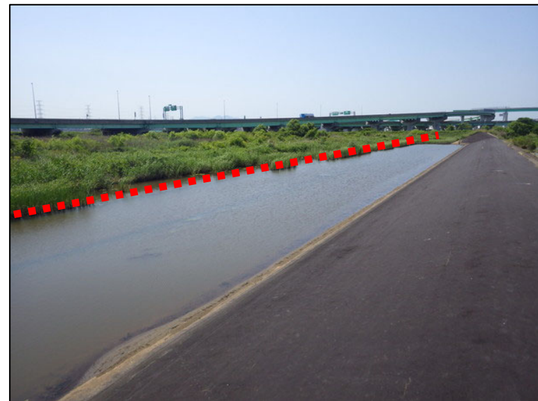
勿来川遊水地（多賀城市南宮地内）
