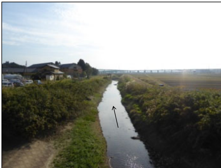
砂押川（宮城郡利府町加瀬川迎地内）
