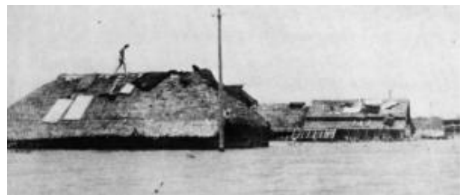
吉田川の破堤で軒下まで浸水（鹿島台町）
