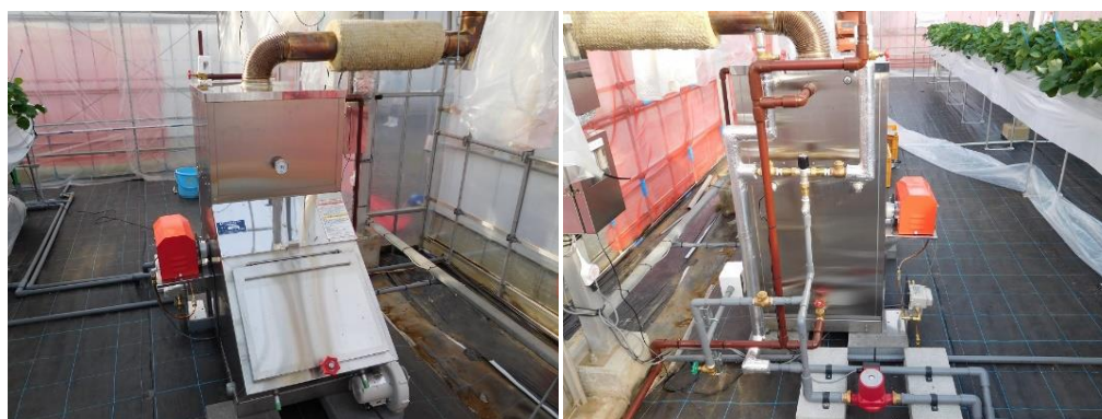
図1 ウッドボイラーS-220NSB（左：正面、右：背面）
