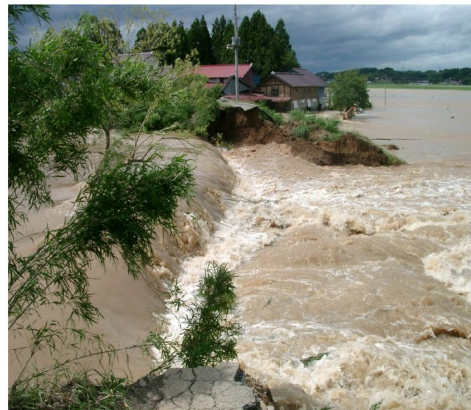
二迫川破堤状況写真 (H14. 7. 11台風6号)
