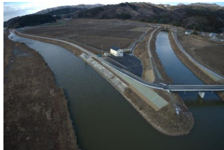
大沢川（石巻市）
