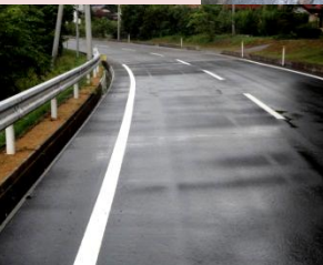
▲大島線(県道208号)着工前と復旧後
