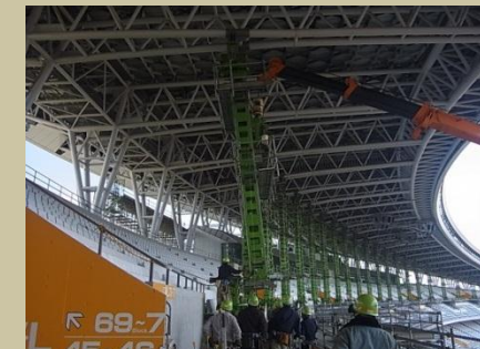
▲スタジアム屋根に仮設柱を設置
