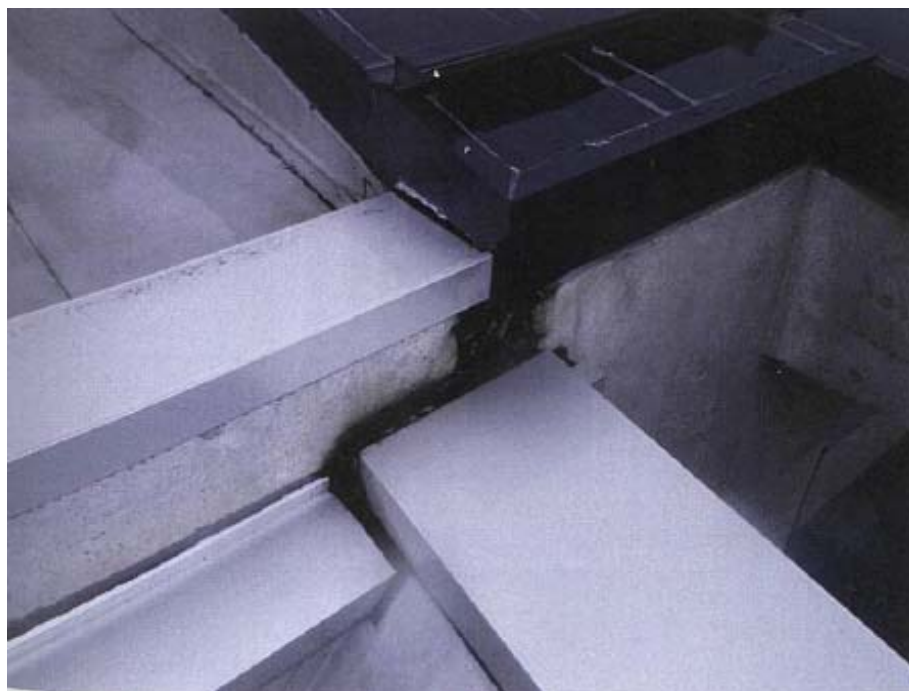
平成30年度改修設計時の調査写真 (ガラスストーム屋上)
