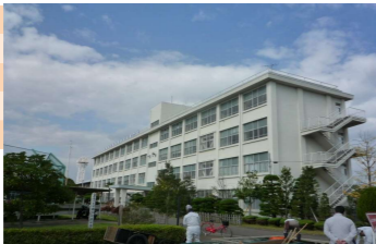
仙台高等技術専門学校 本館 全景
