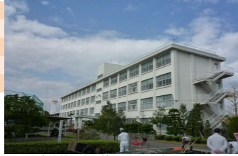
仙台高等技術専門学校 本館 全景
