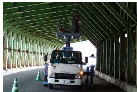
点検状況(高所作業車)
