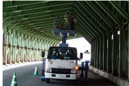
点検状況(高所作業車)
