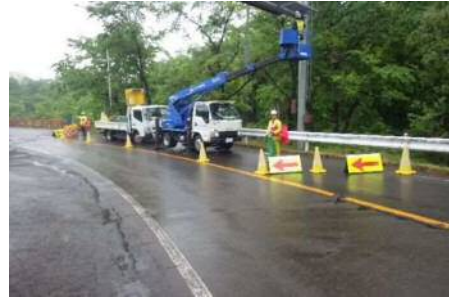
点検状況(高所作業車)
