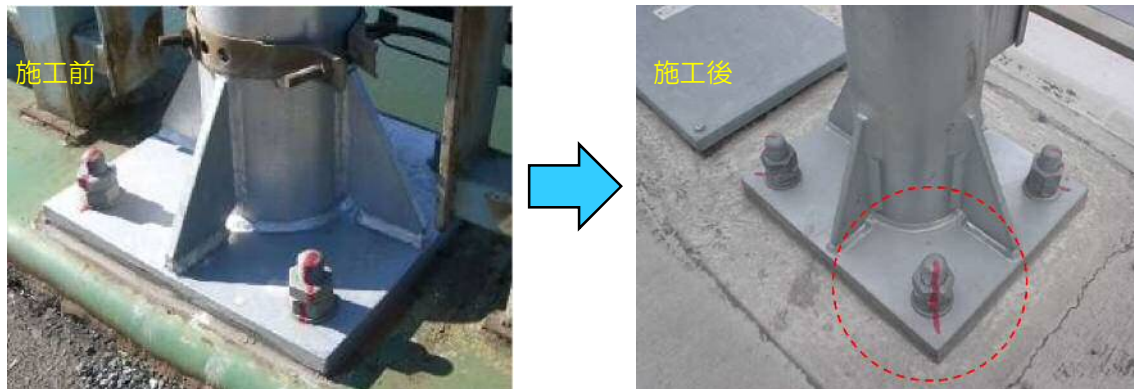
図 5-2.ボルト増し締め工例
