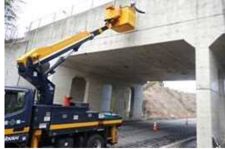
点検状況(高所作業車)
