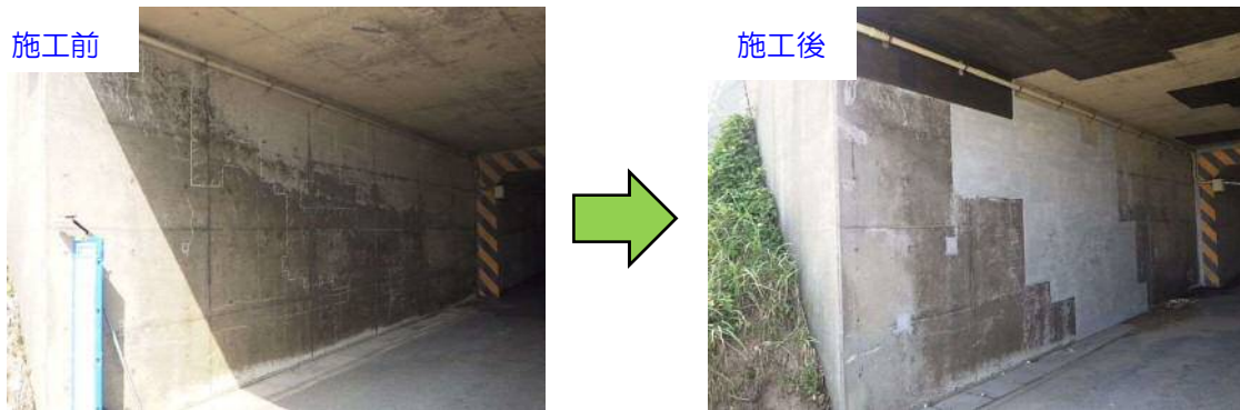
図 5-3. 断面修復工の例
