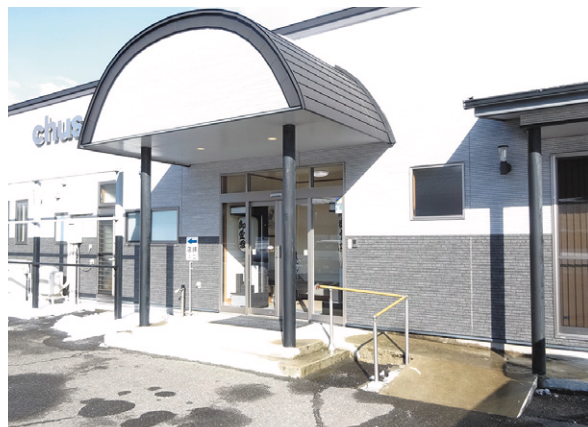
会館入り口のスロープ
