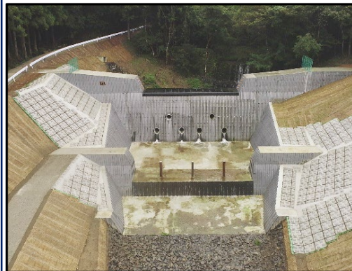
砂防堰堤の整備
