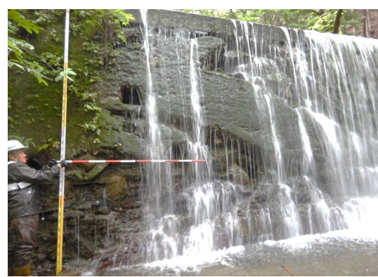
既設コンクリート堰堤の補強
