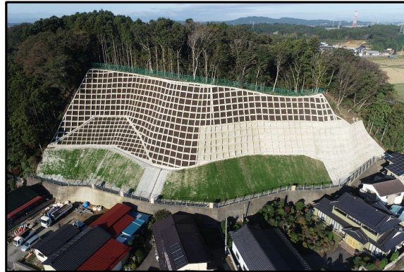
急傾斜地崩壊対策施設の整備
