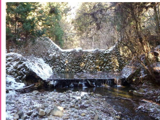
石積堰堤の改築
