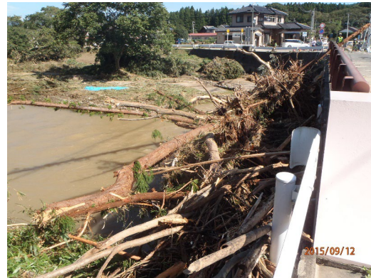
流木被害 (平成27年 関東・東北豪雨 仙台市)
