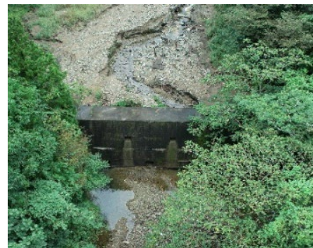
写真2 UAV点検の例(女川町)
