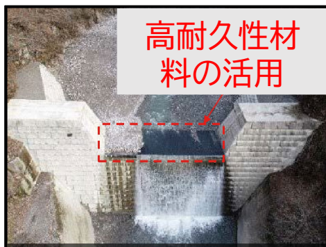
写真1 高耐久性材料による天端摩耗の補修の例
