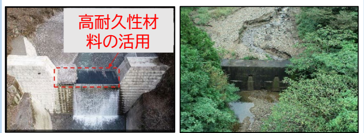
写真1 高耐久性材料による天端摩耗の補修 写真2 UAV点検の例(女川町)
