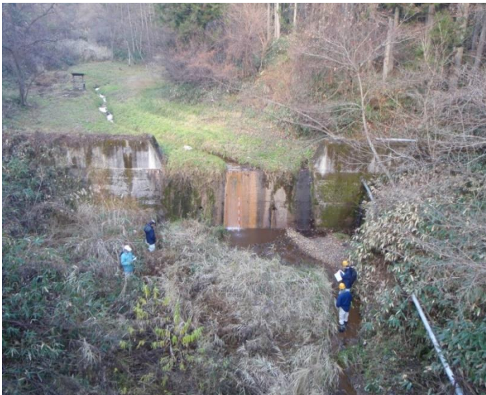
(左写真) 治山ダムの目視点検
