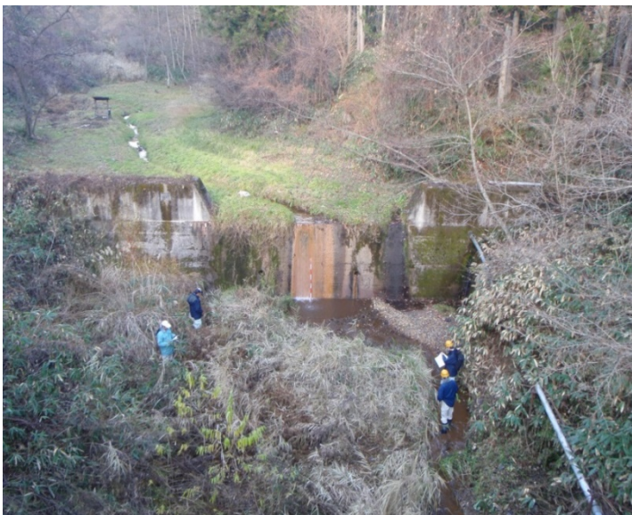
(左写真) 治山ダムの目視点検
