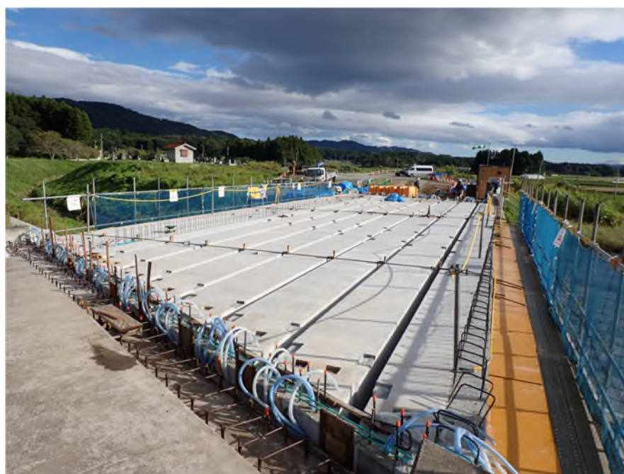
諏訪橋 施工状況
