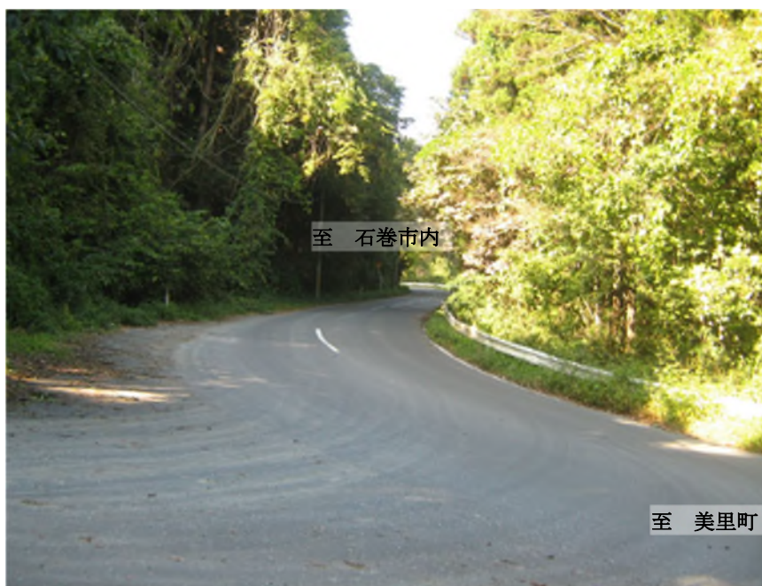
線形不良箇所
