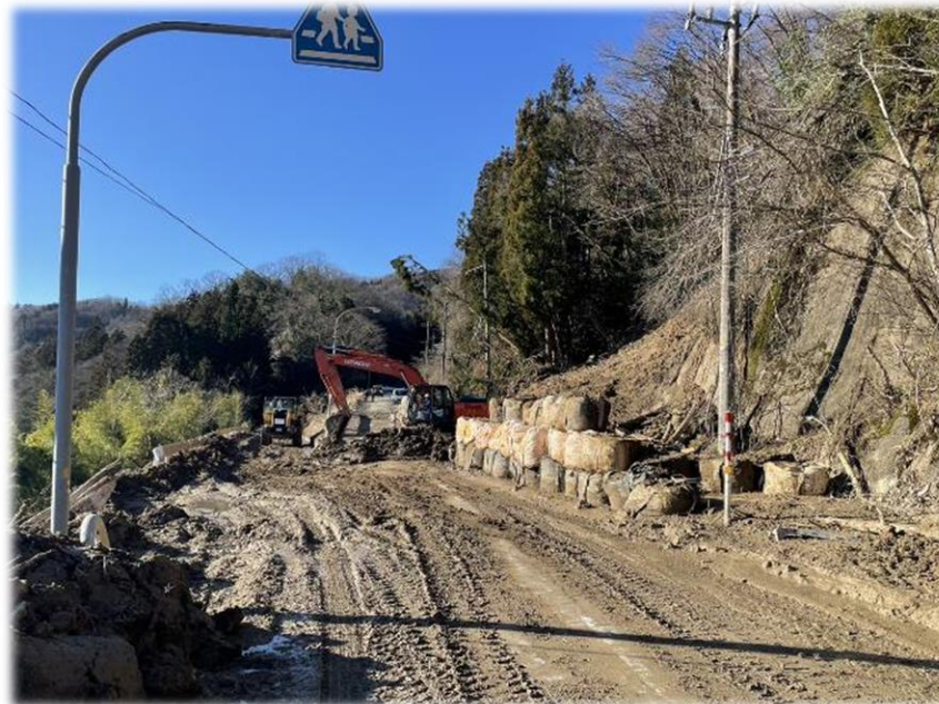
県道の復旧作業状況（輪島市内）
