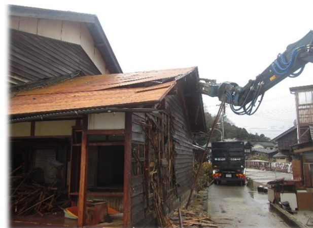
公費解体の様子
