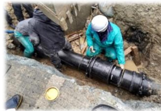
水道管の復旧作業状況（輪島市）
