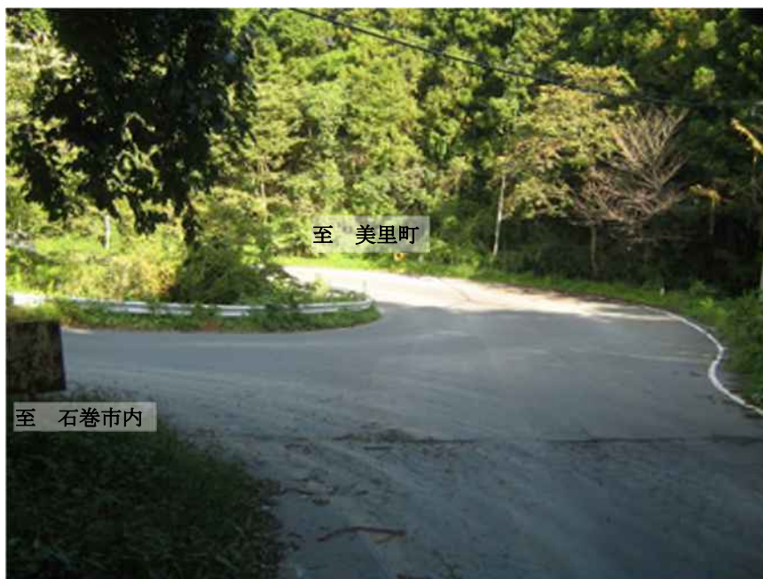
線形不良箇所
