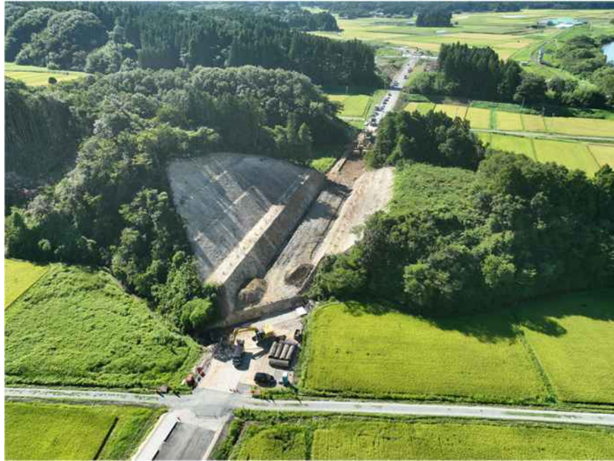
道路改良工 施工状況
