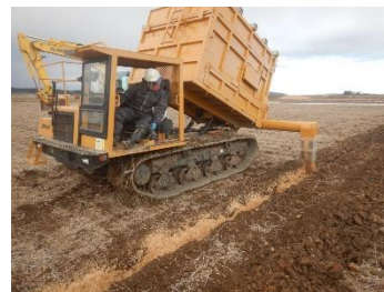
もみ殻補助暗き施工の様子
