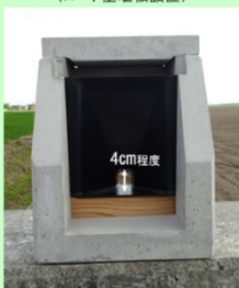
田んぼダム型排水柵 (ロート型堰板設置)
