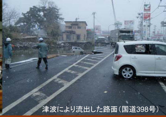
道路両側に山積みとなった瓦礫(国道398号)
