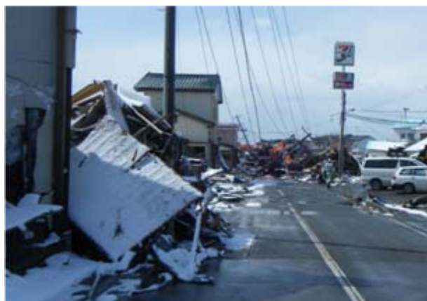
国道398号 渡波地区の瓦礫堆積状況
