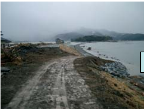
国道398号 針岡地区
