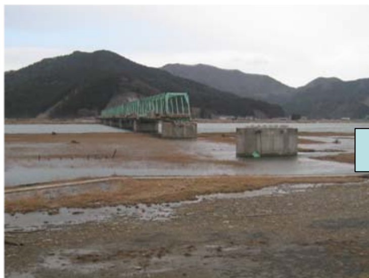
国道398号 新北上川大橋
