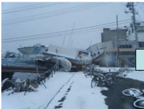
国道398号 内海橋
