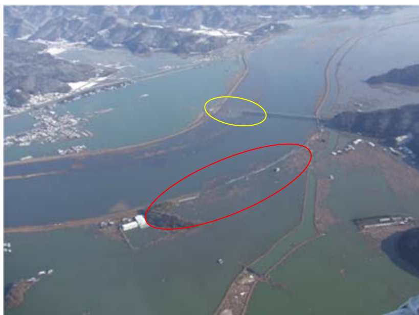
国道398号 新北上大橋の落橋(黄色) 河北桃生線 北上川堤防上の道路が流出(赤色)
