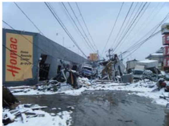
国道398号 鹿妻地区の瓦礫堆積状況
